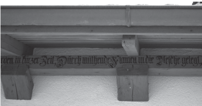
Dachbalken, Dorfstrasse 33, Grafstal
