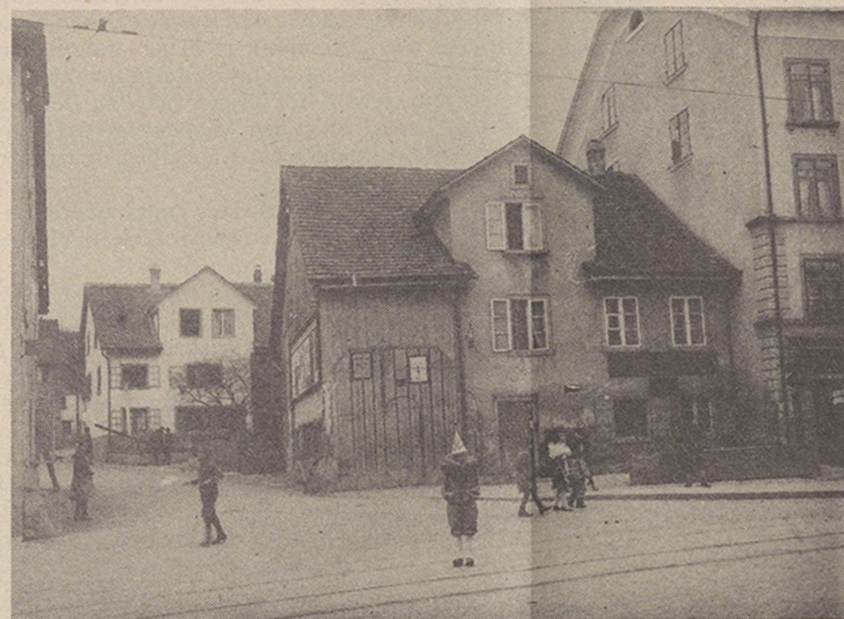
Haus von Chueri Notz beim Lindenbrunnen, 1927, kurz vor dem Abbruch
