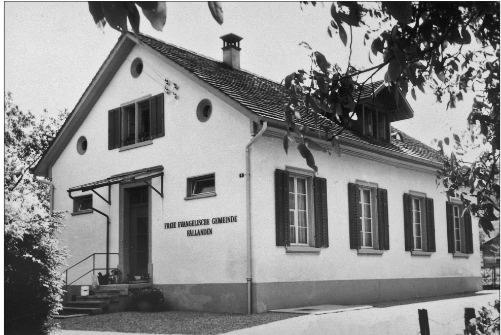
Abbildung 39 Das Versammlungslokal der FEG an der Wigartenstrasse, im Volksmund Kapelle genannt, wurde 1982 ab- gerissen und durch einen Neubau ersetzt.
