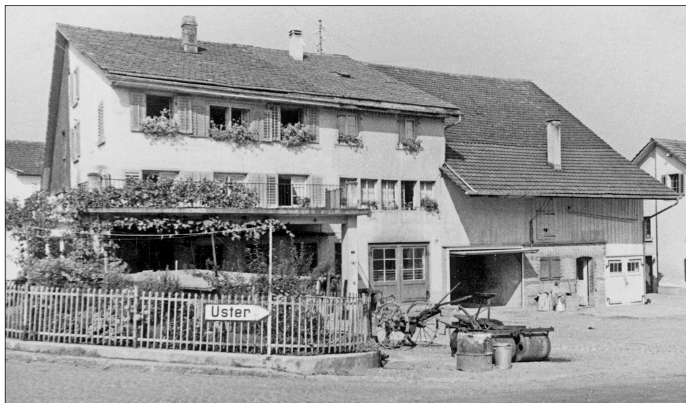
Abbildung 3 Wohnhaus mit Schmiede Ecke Schwerzenbach-/Dübendorfstrasse. Der Teil rechts unter dem Vordach gehörte zum Restaurant «Kreuz». 1970 wurde das Gebäude durch eine Feuersbrunst zerstört, die Brandruine aber erst 12 Jahre später abgerissen!
