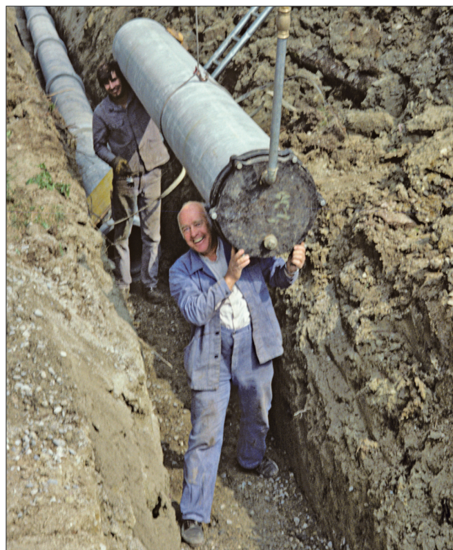
Abbildung 4 Ernst Attinger beim Bau der Wasserleitung (ø 600 mm ) Dübendorf–Schwerzenbach
