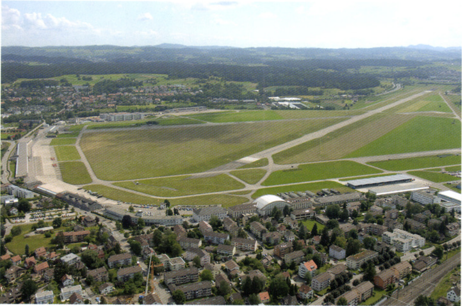
Blick über das weite Flugplatzgelände Richtung Wangen. Dort steht das neu erstellte Skyguide-Gebäude und rechts davon die Halle 10 für Helikopter.
