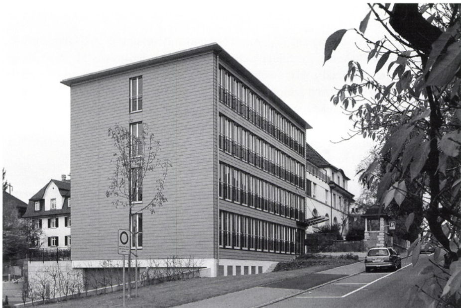
Das FAI-Gebäude von der Casinostrasse aus gesehen. Im neuen Teil sind der Testsaal, die Psychologie und die Fitnessräume untergebracht. Im Altbau, rechts, befinden sich die Labors, die Unterdruckkammer und die Räume der ärztlichen Mitarbeitenden.
