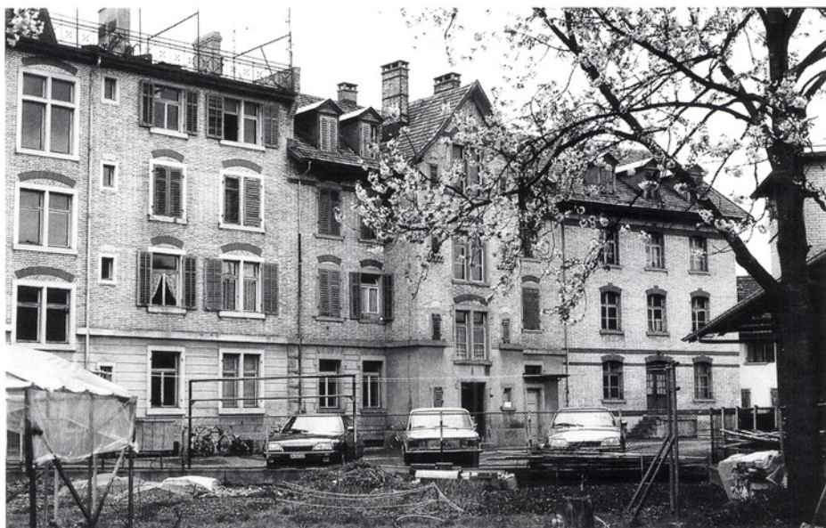
Die Rückseite des Gebäudes der Konsumgenossenschaft an der Usterstrasse. Seit 1940 wohnte hier die Familie Eugster-Noser im 2. Stock, im Haus mit der Zinne.
