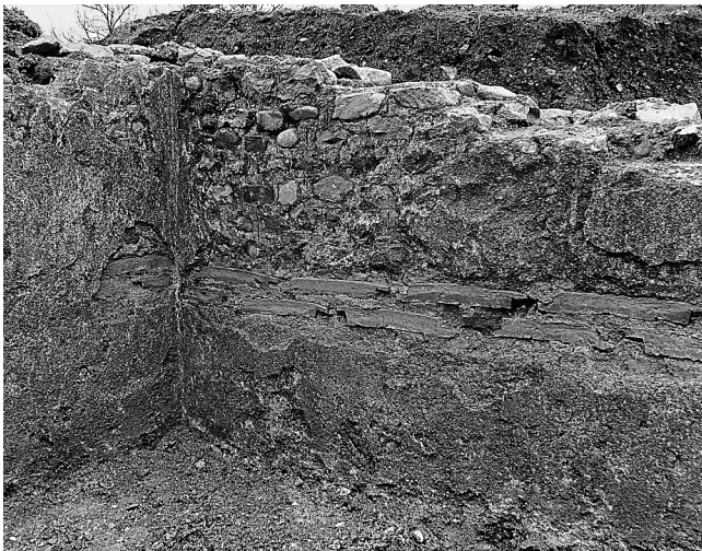
Abb. 14. Urdorf-Heidenkeller. M. 7 und M. 9 mit Entfeuchtungsziegel-lagen in R. 7.
