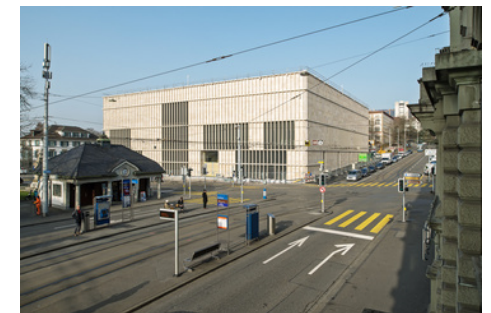
Neues Wahrzeichen am Heimplatz: Der Kunsthaus-Erweiterungsbau (Foto: HAL_011095, Juliet Haller)
