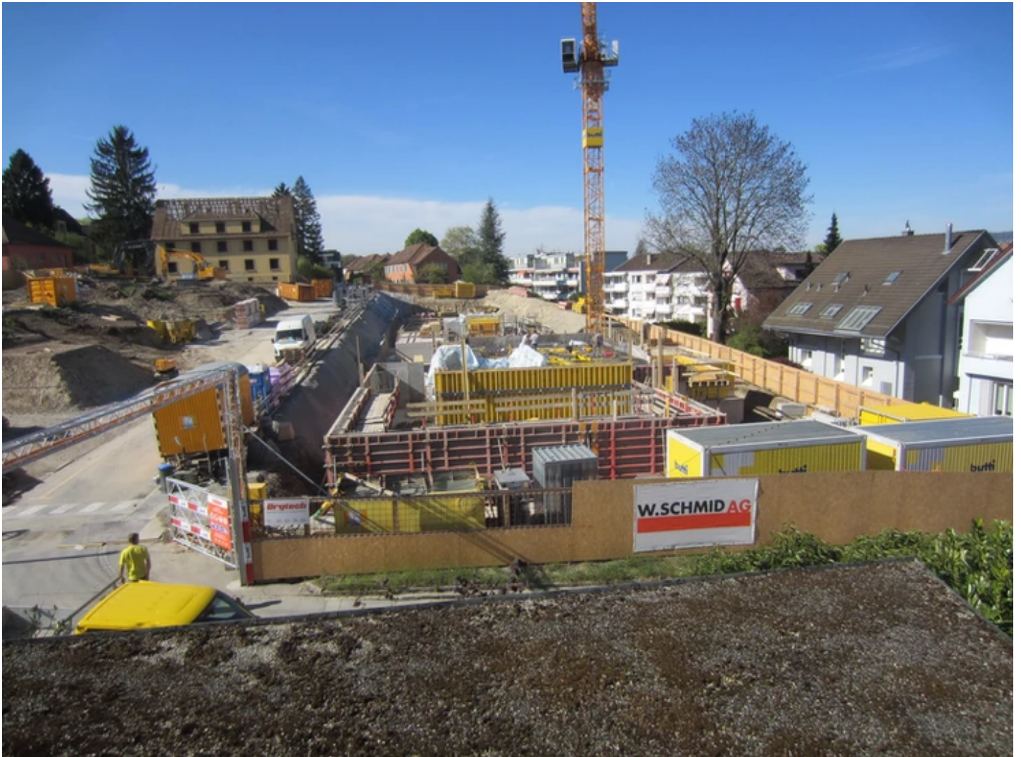
Baustelle Siedlung Balberstrasse am 17. April 2014. Foto Ali Punter, Zürich.
