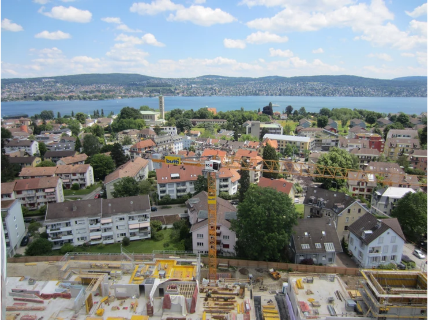
Sicht vom (2.) Kran (Baustelle Balberstrasse) am 16. Juni 2014. Foto Ali Punter, Zürich.
