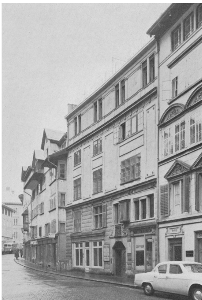
Tannenberghaus, vor dem Umbau.
