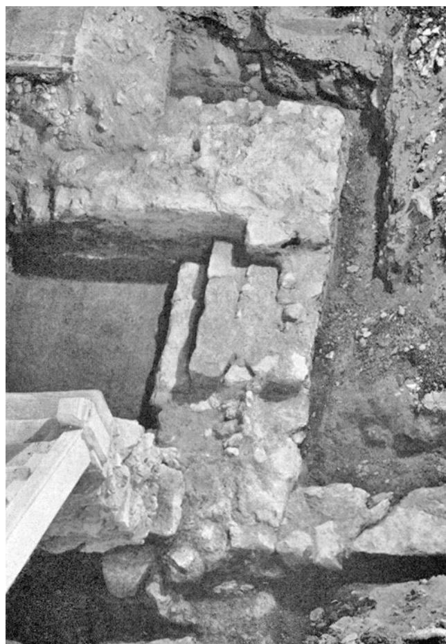
Hombrechtikon – Reformierte Kirche. Baureste eines profanen Gebäudes westlich der gotischen Kirche.
