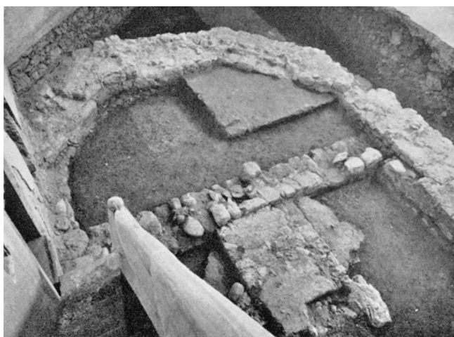
Hombrechtikon – Reformierte Kirche. Die freigelegten Fundamentreste der romanischen und gotischen Choranlagen, im Vordergrund des romanischen Altares.
