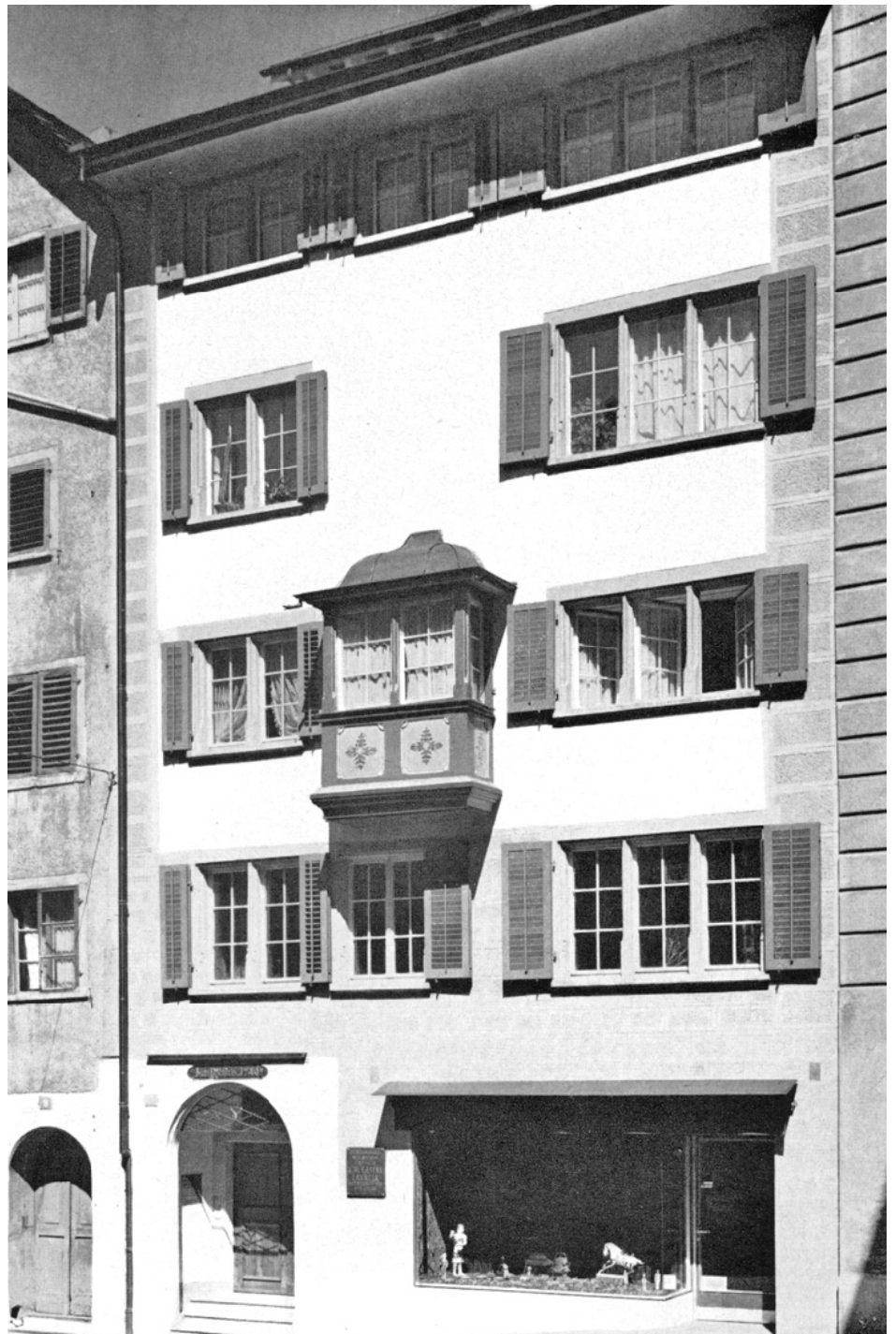
Spiegelgasse 11, Südfassade nach dem Umbau 1957.
