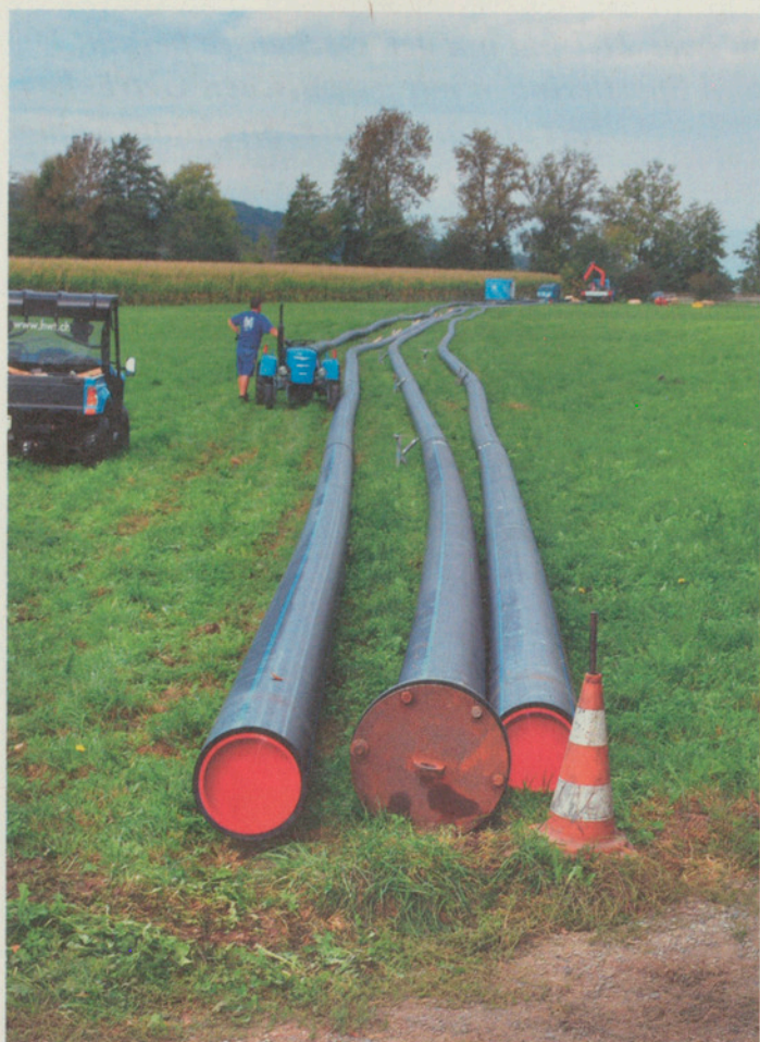
Die PE-Plastikrohre werden auf einer Wiese bei der Badi Maur verschweisst und warten auf Rollen auf ihre Einwässerung Ende Oktober. An der Schiffflände steht derweil ein improvisiertes Boot für die Arbeiten auf dem See bereit.
