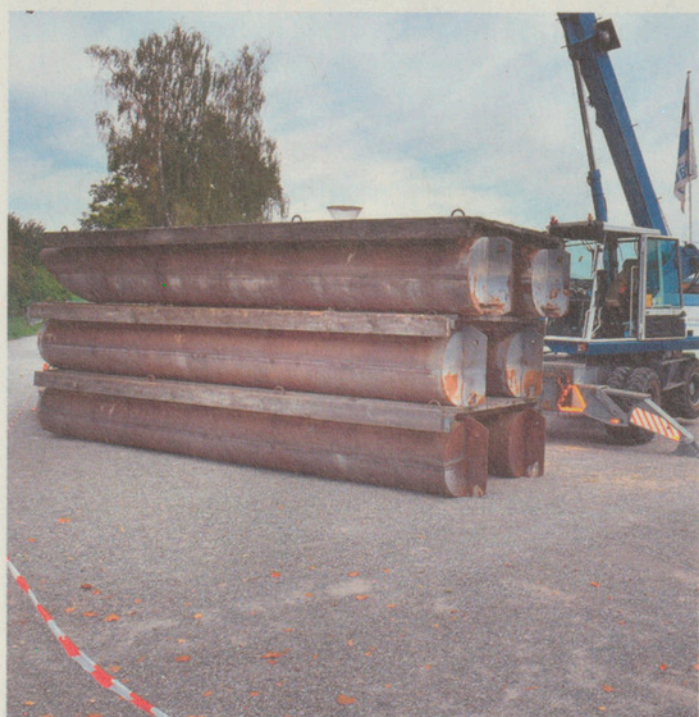
Pontons für die Arbeiten auf dem See.
