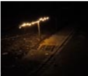
Selbst installierte Beleuchtung
