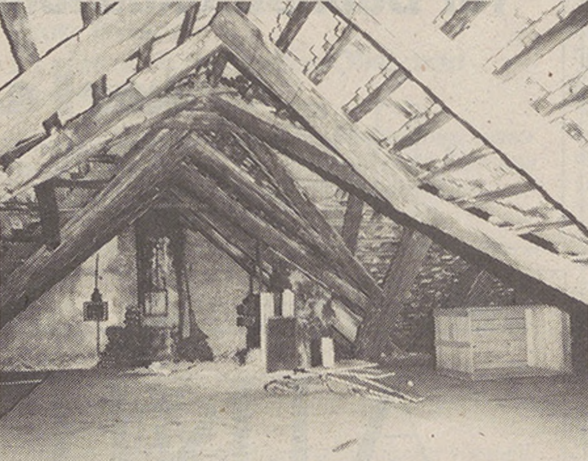
Abbildung 5 Dachstuhl gegen Süden (Giebelmauer mit Kamin); Blick in Richtung des vermutlich 1730 erstellten Firstes; quer dazu der Anbau von vermutlich ca. 1740/45. (Photo Baugeschichtliches Archiv der Stadt Zürich, aufgenommen während Umbau 1984/85)
