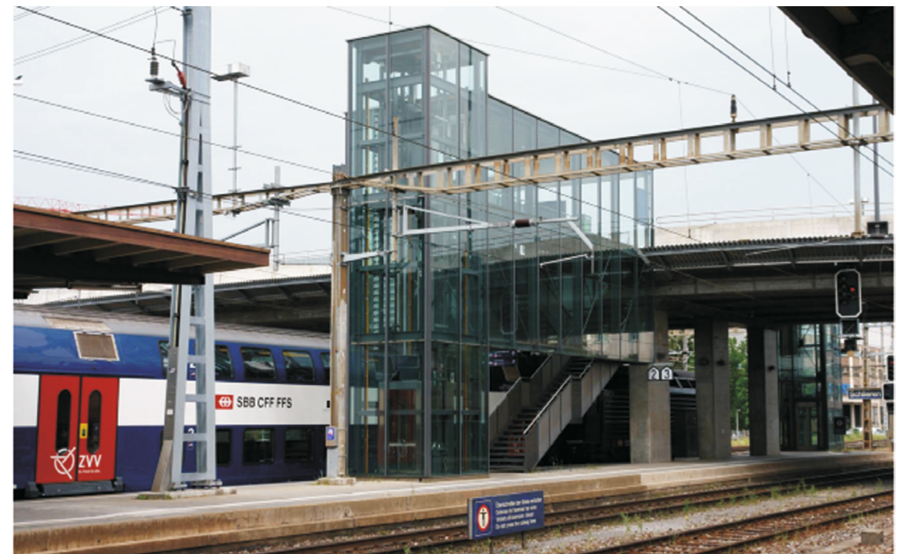
Direktzugänge ab den Bahnsteigen 2 und 3 zu den Brückenhaltstellen der ZWV-Buslinien nach der Brückensanierung 2004.
