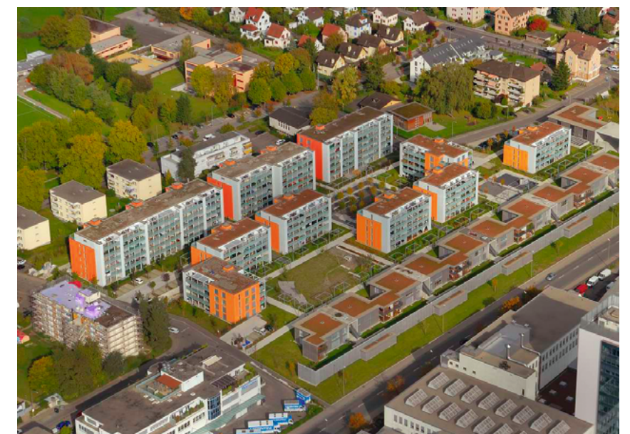
Im Wandel der Zeit. Erstes Bild: Vor Baubeginn; Zweites Bild: 1. Etappe abgeschlossen; Drittes Bild: Überbauung nach Bauabschluss.
