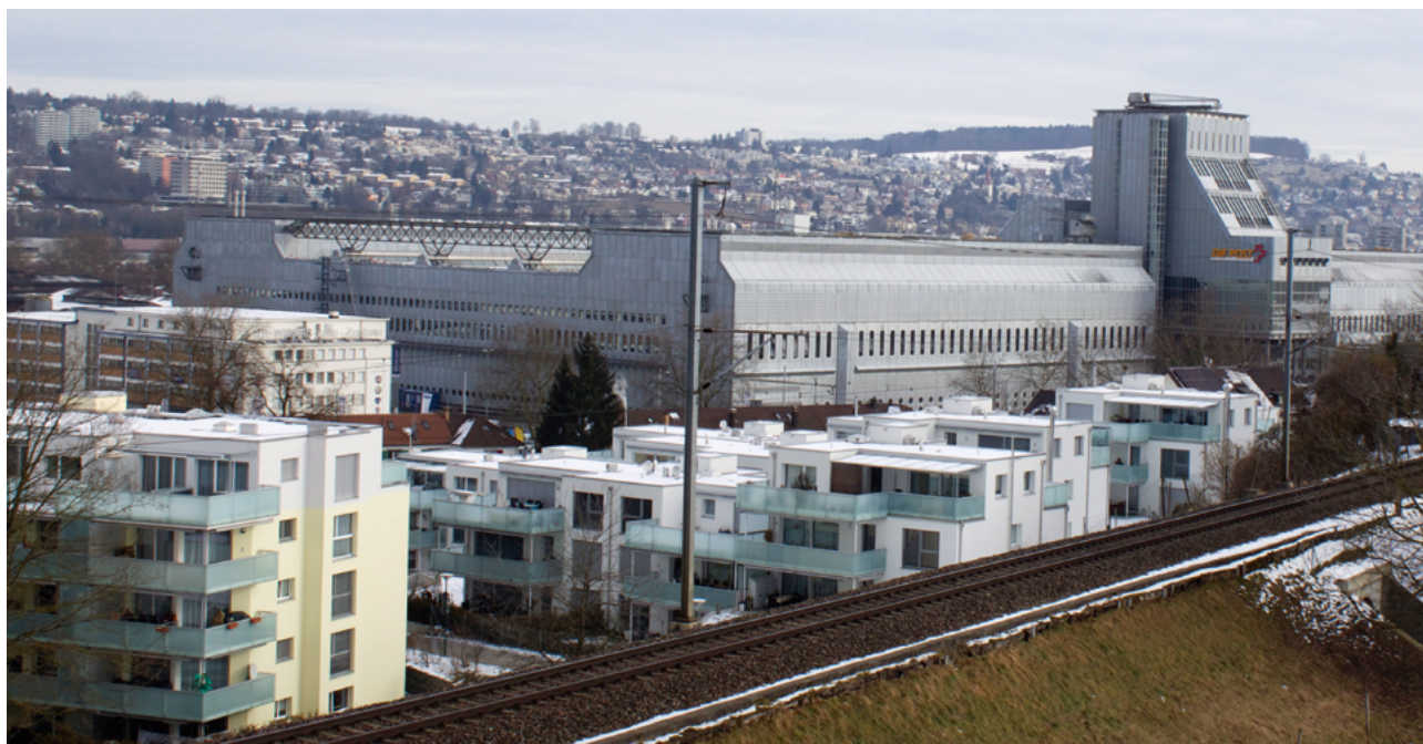
Blick auf die neuen Wohnhäuser mit dem Briefzentrum im Hintergrund.
