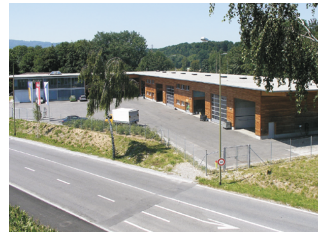
Neuer Werkhof an der Bernstrasse (2003) in Holzbauweise.
