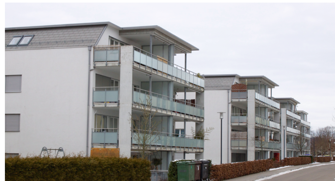
Blick nach Osten durch die Trislerstrasse mit der Überbauung auf der Seite.
