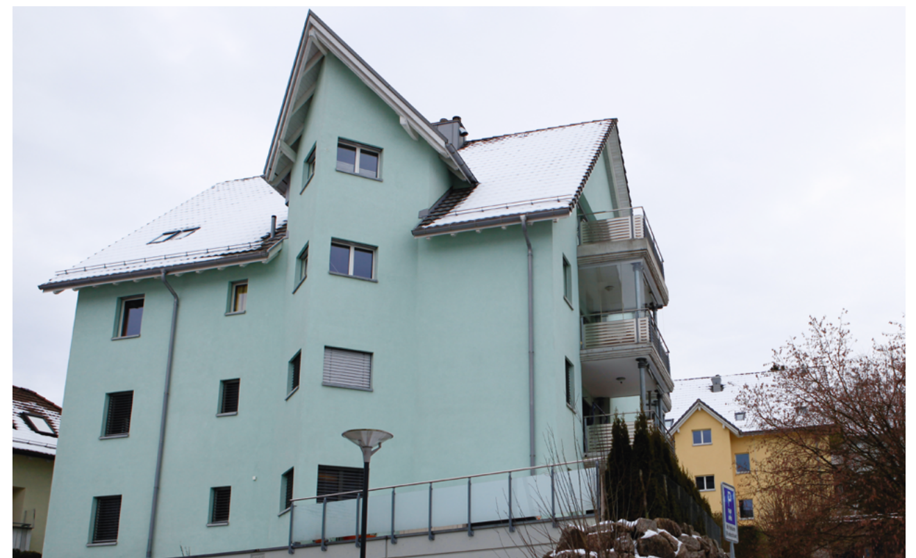
Neubauten entstanden an der Sägestrasse auch neben dem Feuerwehr-Depot (Haus Sägestrasse 18).
