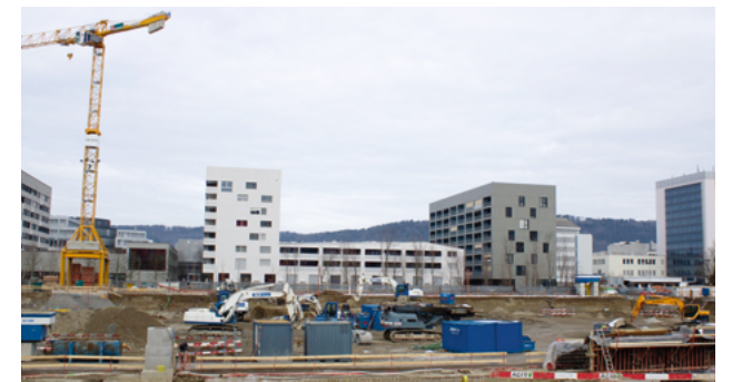
Baugrube nördlich der Goldschlägi-Unterführung mit Blick gegen den Rietpark und die Brandstrasse, aufgenommen im Januar 2013.
