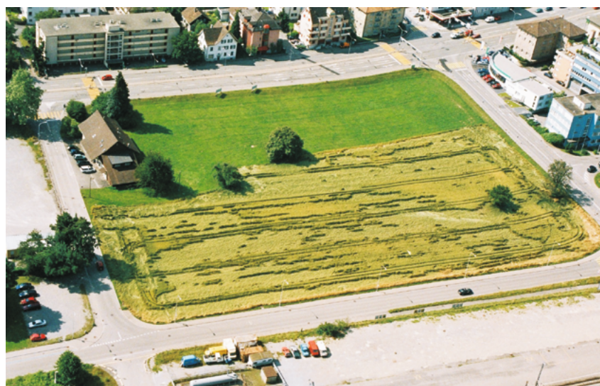
Das Areal Geissweid vor der Überbauung.
