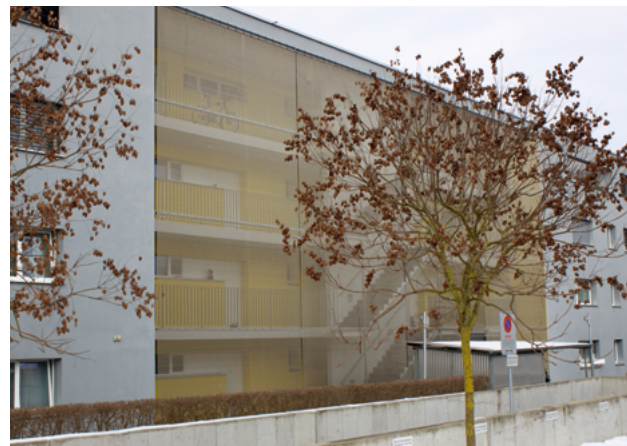
Wohnhaus mit Lärmschutz an der Zürcherstrasse.
