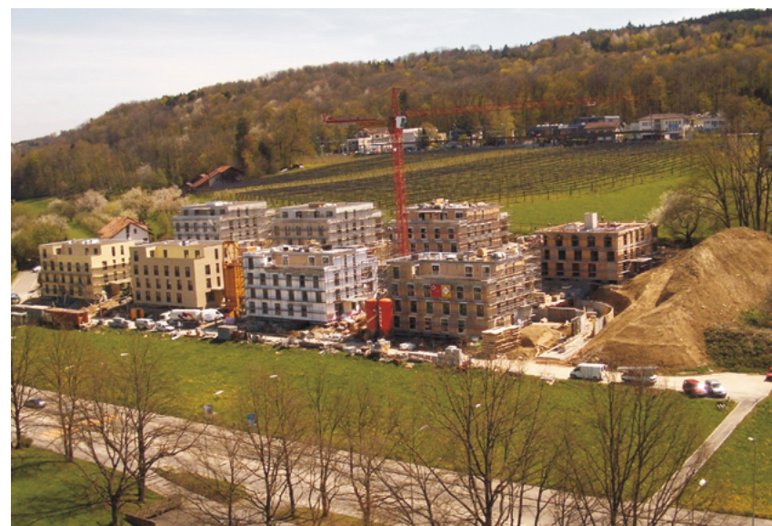
In einem ersten Schritt entstehen die Häuser Trislerstrasse 1 – 15 mit Eigentumswohnungen, bezogen 2004. Das Foto zeigt die Häuser südlich der neu erstellten Trislerstrasse im Rohbau.
