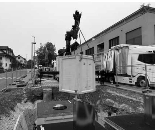
Montage der neuen Unterflurcontainer.
