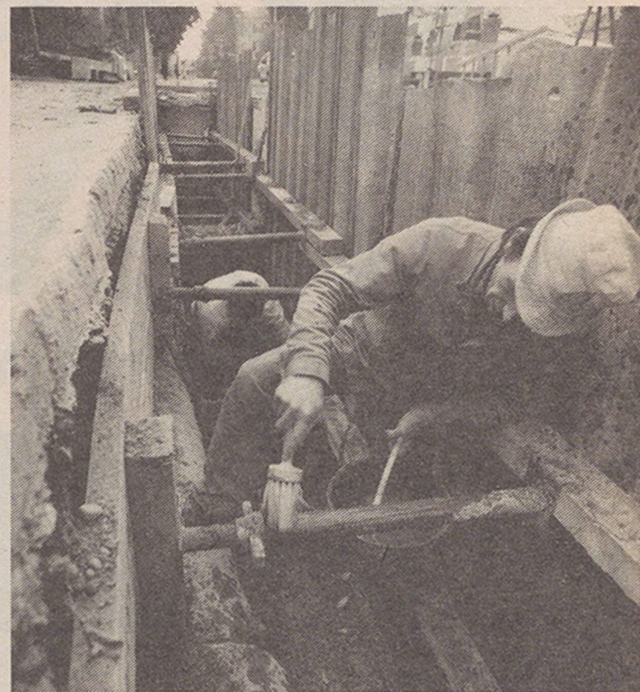
Arbeiten in einem Graben für den Werkleitungsbau
