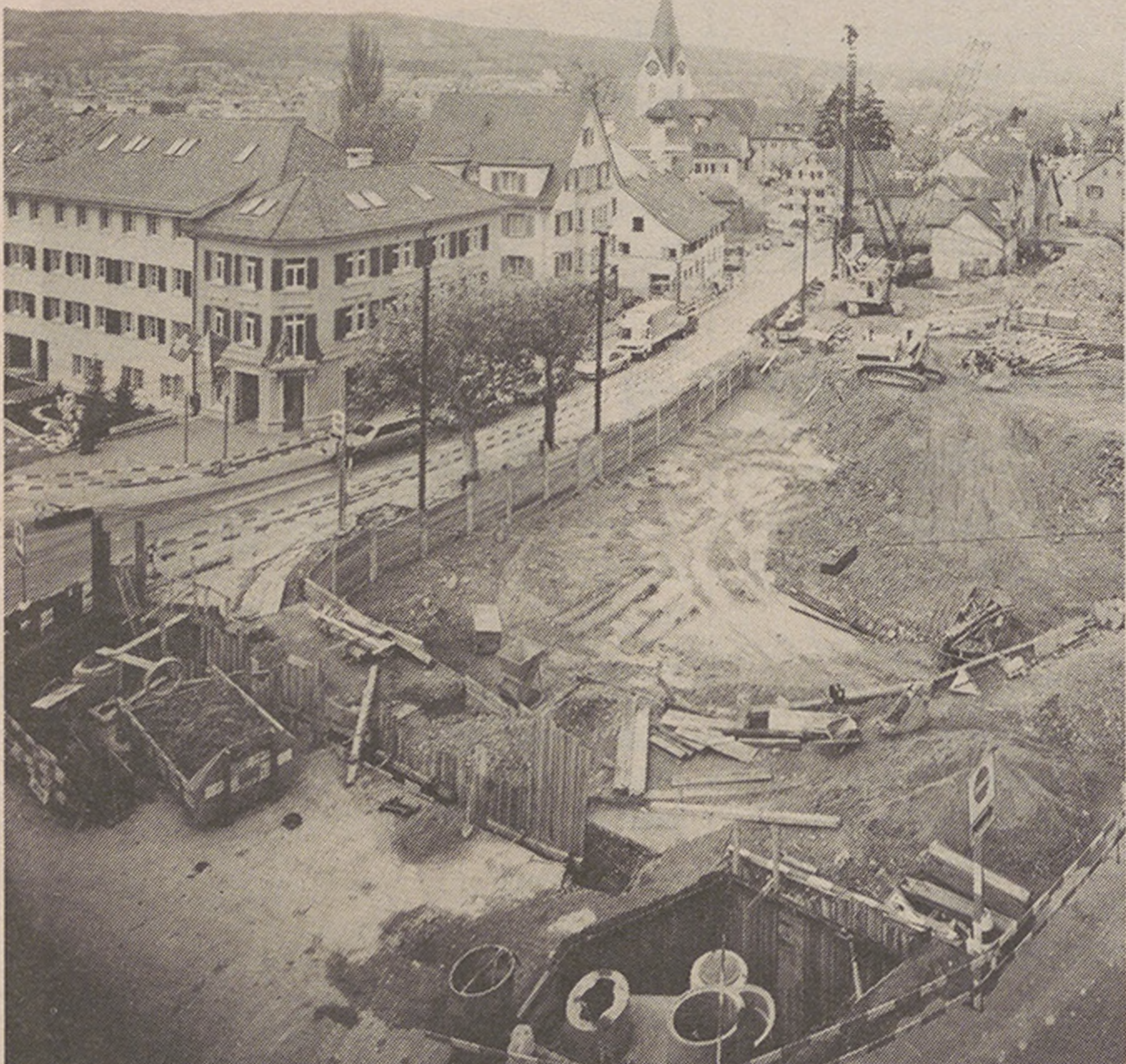
Blick vom Postgebäude auf die Baugrube für den zukünftigen Höngger Markt
