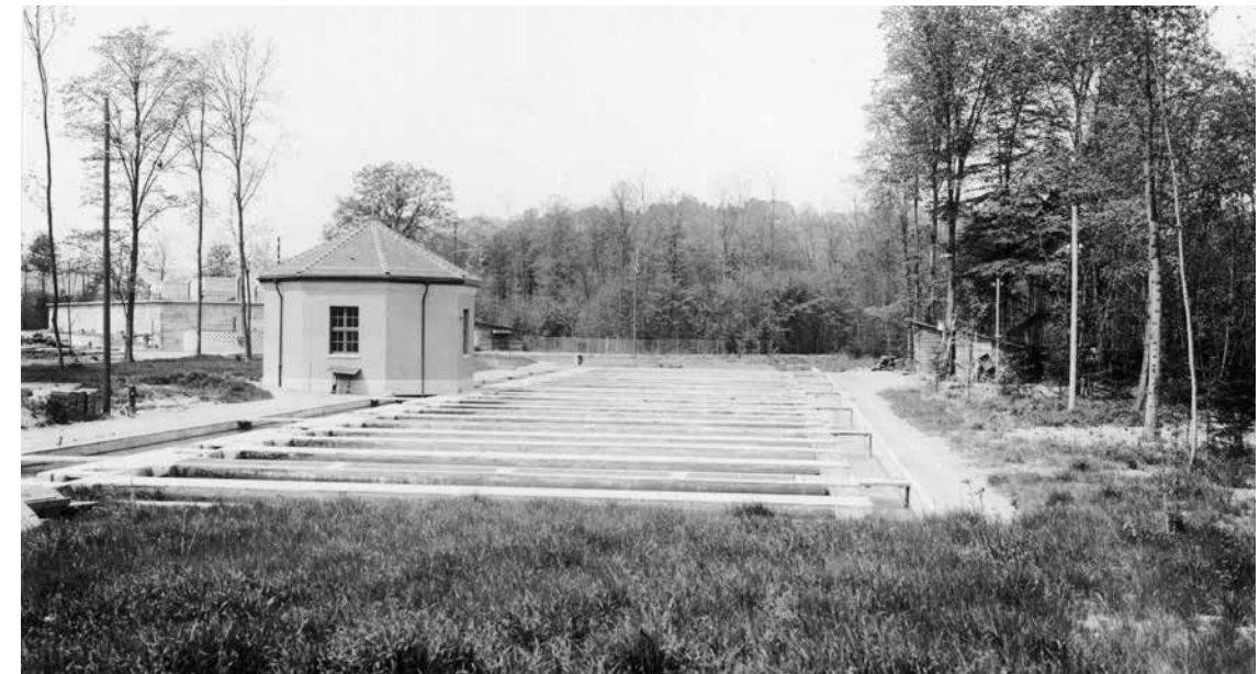
Kläranlage Werdhölzli in Zürich-Altstetten. Das Absetzbecken (im Bild) war in der Anfangszeit ungenügend dimensioniert, und es folgten keine weitere Reinigungsstufen. Hier wurde auch das Abwasser aus Kilchberg gereinigt. Fotografie, 1926.
