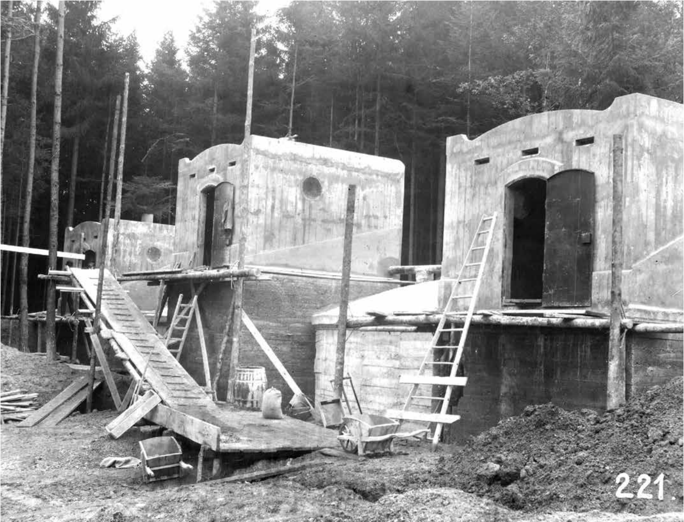
Der Teilstock am Ende der Rothenthurmer Leitung mit den beiden Doppelreservoirs Kopfholz in Rüschlikon im Bau. Die innere der beiden Kilchberger Rundkammern ist noch nicht mit Erde bedeckt. Fotografie, 1907.
