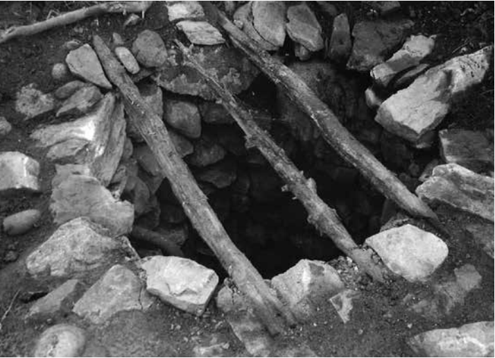
Sodbrunnen an der Kreuzstrasse. Der längst vergessene Schacht kam beim Abbruch der Scheune Welti-Leuenberger überraschend zum Vorschein. Fotografie, 1977.
