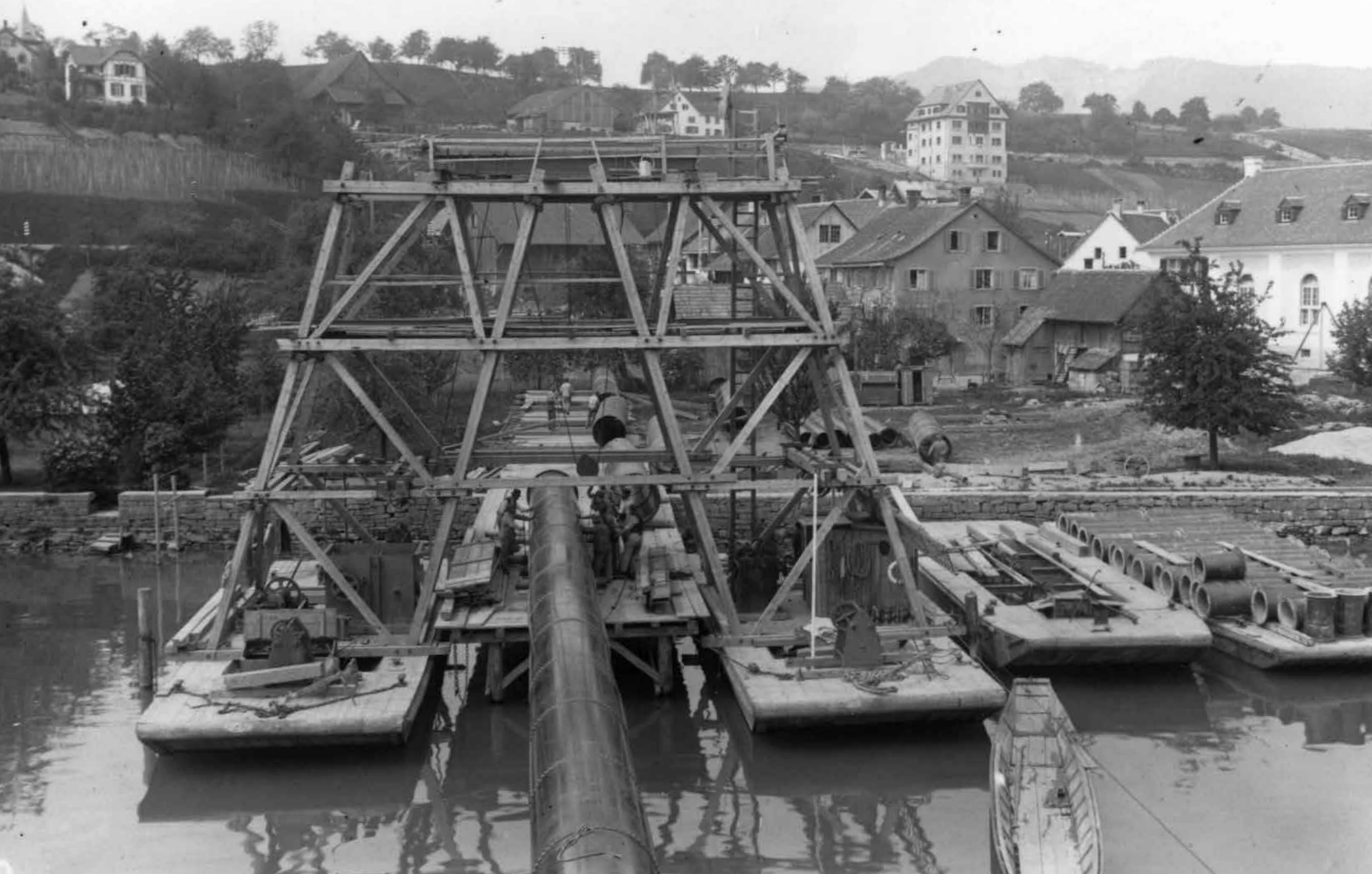
Verlegung der Rohre der Rohwasserfassung für das Seewasserwerk Moos in Zürich-Wollishofen beim Horn an der Zürcher Stadtgrenze zu Kilchberg. Fotografie, 1913.
