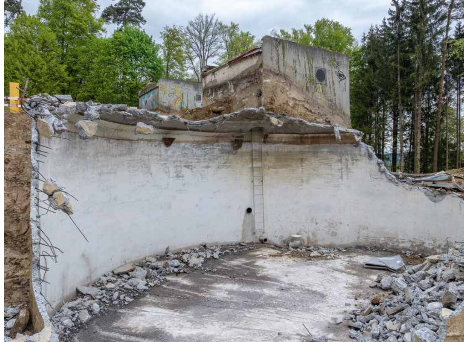
Im Frühling 2025 wurden als erstes die beiden Rundkammern der Gemeinde Rüschlikon abgebrochen: Robert Maillart verwendete ein Minimum an Beton, wie die dünne Schalenwand am linken Bildrand und die Reste der filigranen Decke zeigen. Fotografie, 2025.
