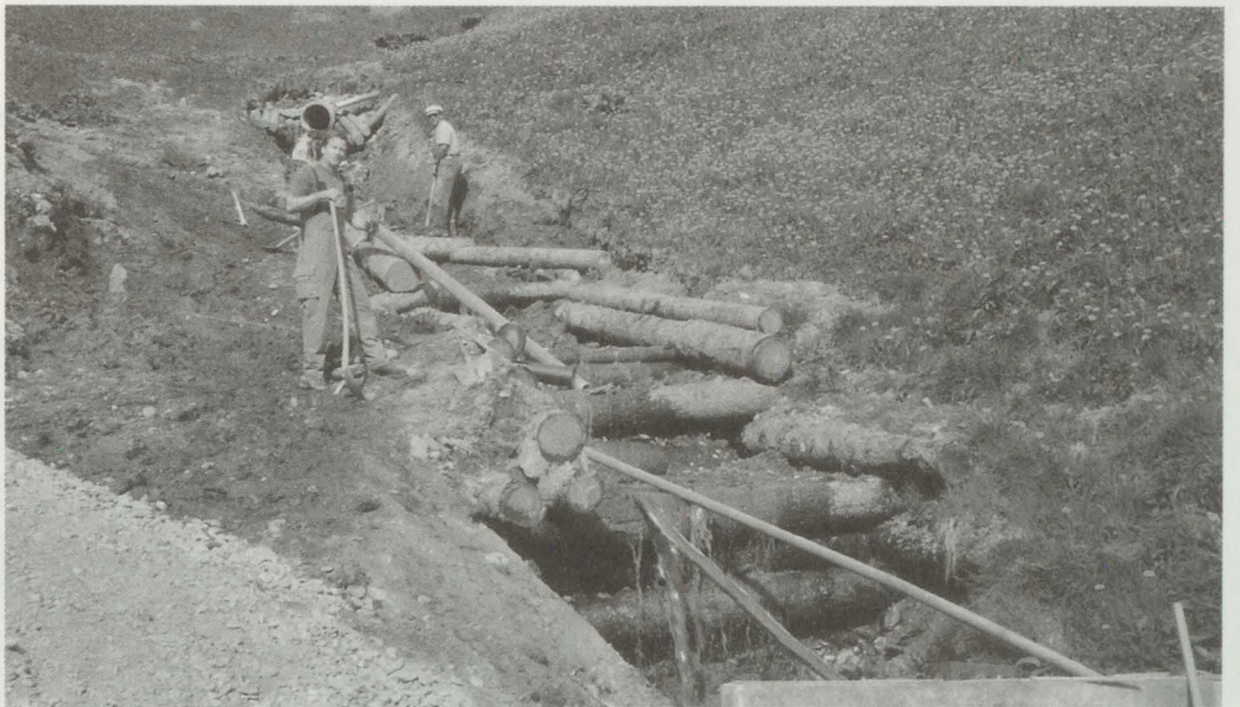
Mit Holztrümmern wurde der Bach neu verbaut, so dass er nicht mehr die Wiesen zu überschwemmen vermag.
