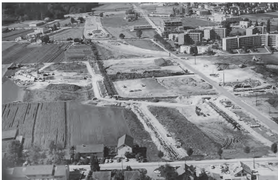
Blick auf die Autobahn-Grossbaustelle 1971, Eröffnung der Strasse 1974.
