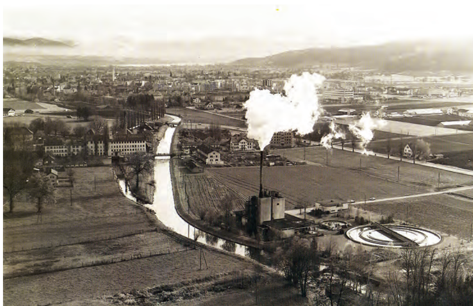
Die 1964 erbaute erste Kläranlage für Wangen-Brüttsellen im Neugut/Dübendorf. Aufnahme von 1967.
