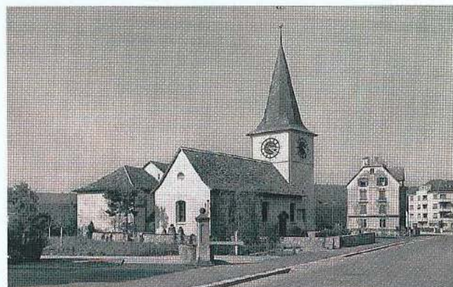
Die Kirche nach dem Umbau von der Kirchgasse her. Deutlich zu erkennen: der erhöhte Kirchturm mit der Uhr.
