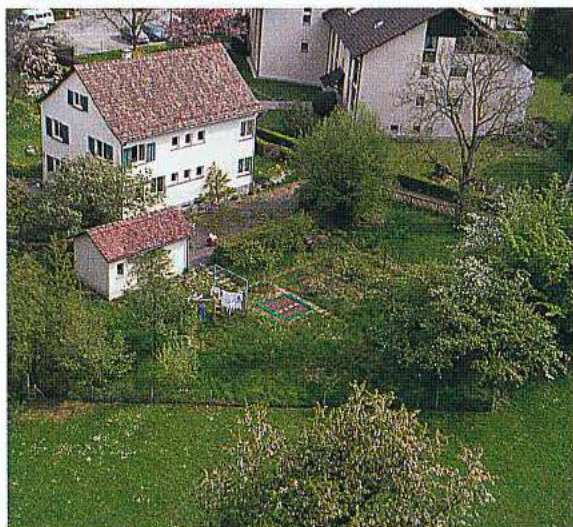
Beim Bau der neuen Kirche hat man 1937 dahinter auch gleichzeitig ein weiteres Pfarrhaus erstellt (mit Zugang von der Kirchgasse her) ...
