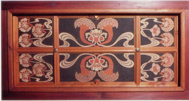
185 Villa Berlepsch, Karlstrasse 29, München-Planegg: Detail der bemalten Kassettendecke in der Diele (siehe auch Abb. 215). Aufnahme von 1990.
