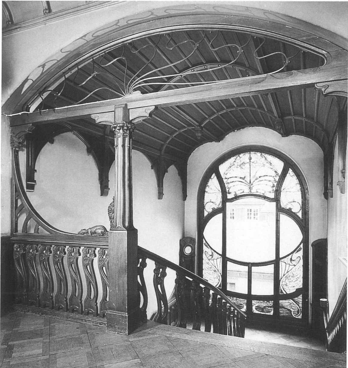
142 Villa Tobler, Winkelwiese 4, Zürich: Blick vom Obergeschoss-podest in die von spätgotischen Vorbildern beeinflusste gewölbte Holzdecke des Haupttreppenhauses. Aufnahme von 1992.
