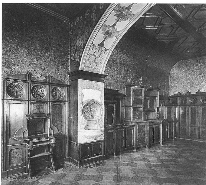
links unten: 159 Villa Tobler, Winkelwiese 4, Zürich: Blick zur Nordwand des Speisezimmers. Aufnahme von 1990.
