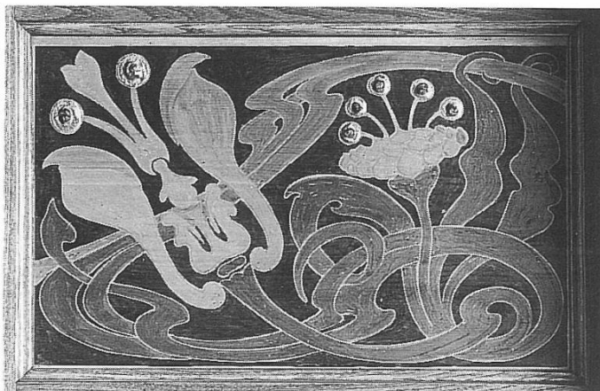
224 Villa Berlepsch, Karlstrasse 29, München-Planegg: Intarsien am Deckenansatz im Wohnzimmer. Aufnahme von 1990. Vgl. Kat. Nr. 12.6.
