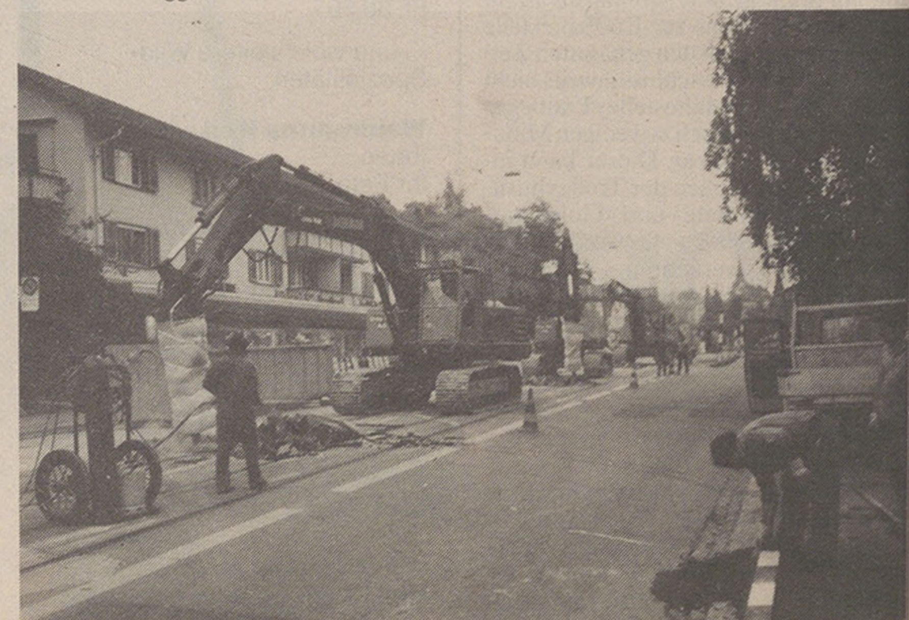
Gleisabbruch an der Limmattalstrasse. Bagger mit riesigen Abbauhämmern reisse den Beton auf.
