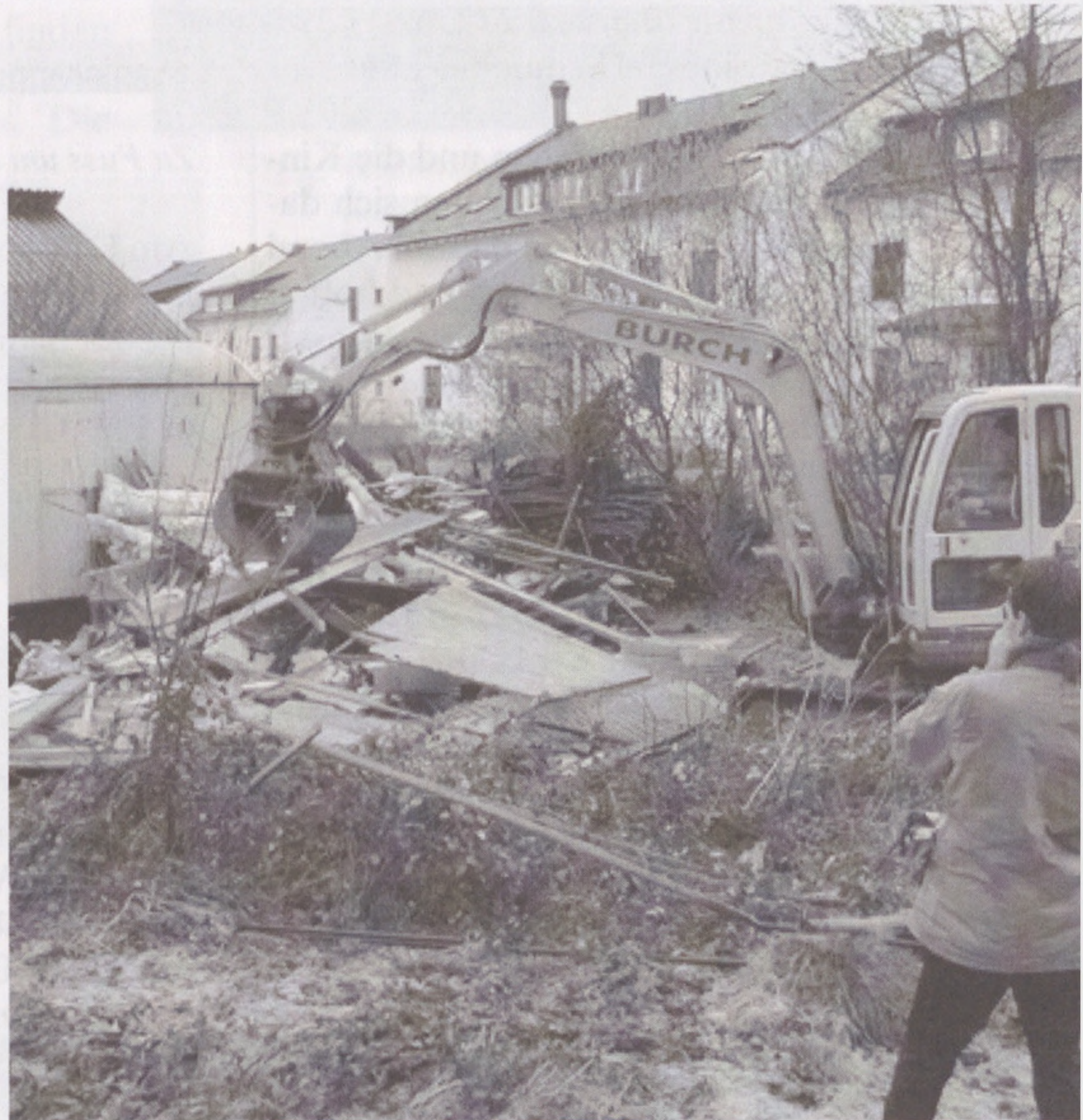
Die illegal erstellte Baracke wurde mit dem Bagger abgerissen und dann entfernt.
