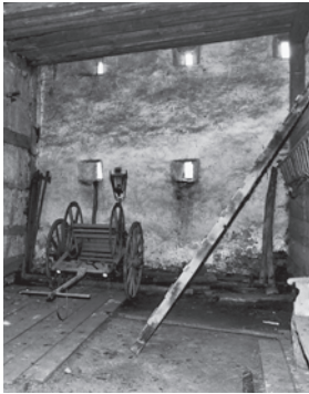
Inneres der Tenne vor der Umnutzung. Zustand Oktober 1998. Fotoarchiv HBA.
