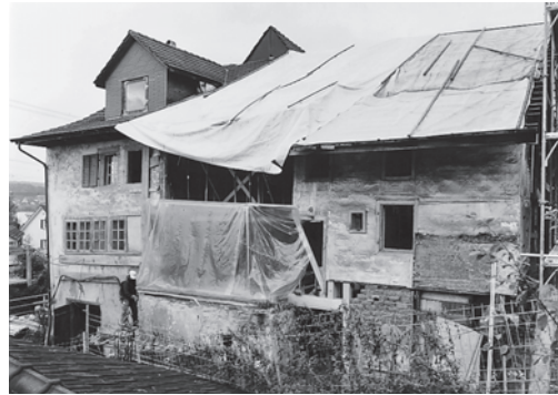
Links: Teilansicht der Ostfassade während des Entfernens der Hohlziegeleindeckung. Zustand Februar 1999.
