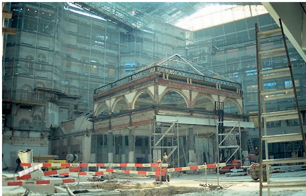
Öffnung des Lichthofs. Der Innenhof wird wäh- rend dem Umbau bis auf die Tragkonstruktion aus- geräumt. Zustand 2001. Fotoarchiv CS.
