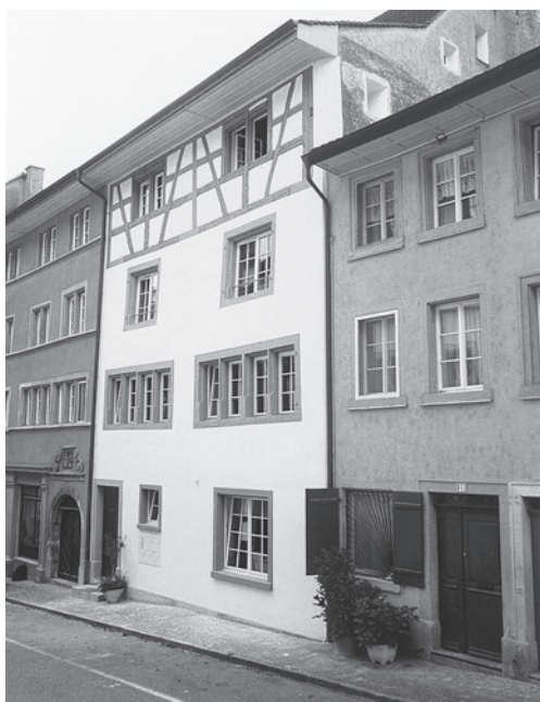
Hauptfassade an der Untergasse. Zustand vor und nach der Restaurierung, Mai 2001 bzw. Juli 2002. Fotoarchiv HBA.
