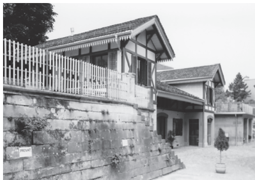
Links: Teilansicht des Nebengebäudes von Westen vor der Renovation. Zustand August 1990. Rechts: Teilansicht von Osten nach der Renovation. Zustand Mai 2002. Fotoarchiv HBA.
