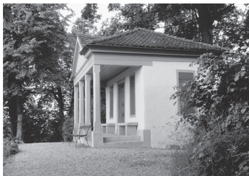
Links: Oberstammheim, Ökonomiegebäude, ehem. Speicher, Keller- und Trottegebäude zum Gasthaus «Zum Kreuz» Vers. Nr. 234, Talstrasse. Vor Abbruch 2002.
