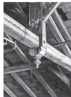
Detail der Dachstuhlkonstruktion des früheren Kantonalen Salzmagazins. Zustand vor dem Abbruch, Dezember 2001. Fotoarchiv HBA.
