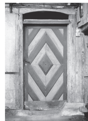
Nordseitiger Eingang mit aufgedoppelter Haustüre und Oberlicht. Zustand Juli 2001. Fotoarchiv HBA.
