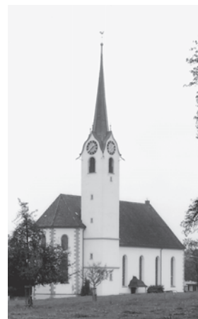
Gesamtansicht von Nord-osten. Zustand 1995. Fotoarchiv HBA.
