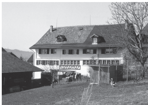
Links: Grüningen, Wohnhaus «Am Aspermont» Vers. Nr. 871, Stedtli, Im Chratz 22. Nach Renovation der Westfassade, Aufnahme 2004.
