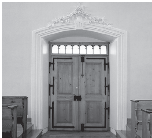
Links: Stuckdekor an der Südwand im Bereich der östlichen Empore. Teilansicht eines Wandpilasters mit markanter Kämpferplatte und bekrönender Stuckurne. Zustand nach der Restaurierung, Juli 2002. Rechts: Westeingang mit Stuckdekor. Zustand nach der Restaurierung, Juli 2002. Fotoarchiv HBA.
