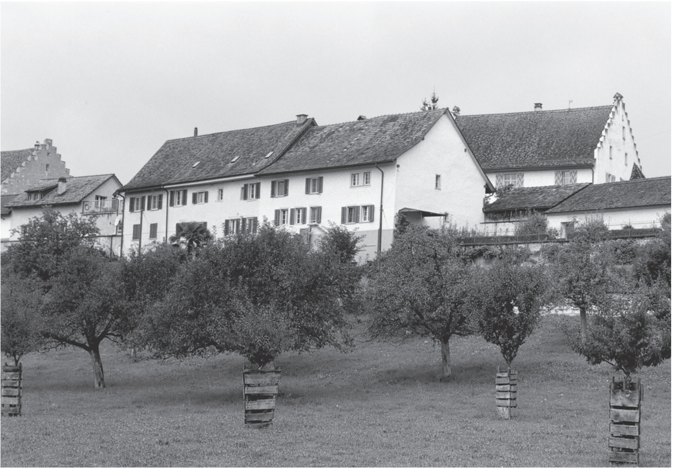
Rheinau, ehem. Bauernhaus
