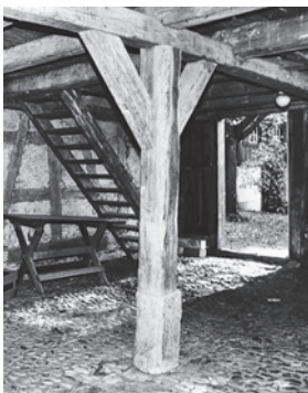
Inneres des Schopfanbaus mit Bollensteinpflasterung sowie Holzstütze mit Unterzug. Zustand Oktober 1998. Fotoarchiv HBA.
