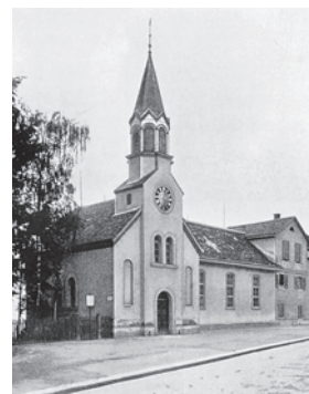
Bethaus «an der obern Strass» von 1734–1735 bzw. 1871 (vgl. Zeittafel). Zustand um 1900. Dok. 10, nach S. 236.
