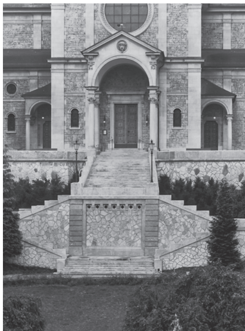
Links: Teilansicht der Treppenanlage vor der Instandstellung mit erkennbaren Schäden. Zustand April 1997. Rechts: Frontalansicht der mittels der Originalpläne Bluntschlis sanierten Treppenanlage. Zustand Mai 1998. Fotoarchiv HBA.
