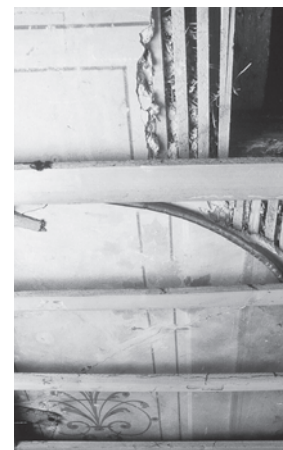
Ausschnitt der Decke des Theatersaals nach der teilweisen Entfernung der neuzeitlichen Verkleidung. Darunter ist die Farbfassung der Gipsdecke erkennbar. Zustand während der Gesamtrenovation, Februar 2001. Fotoarchiv HBA.
