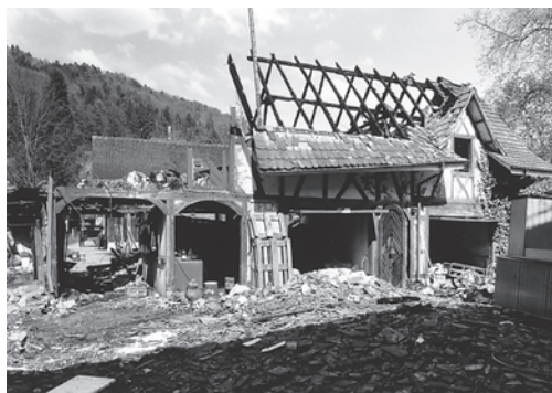
Links: Turbenthal, Güterschuppen SBB Vers. Nr. 14, Bahnhofstrasse bei Nr. 1. Vor Abbruch 2001.
