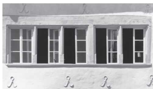
Gekoppelte Stubenfenster an der Ostfassade mit Jahreszahlen «1542» sowie Steinmetzzeichen am Sturz. Links: Zustand Dezember 1972. Rechts: Zustand nach der Restaurierung, August 2001. Fotoarchiv HBA.
