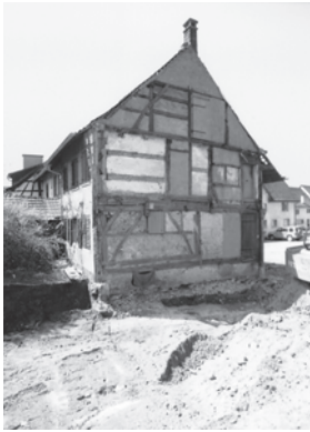
Ansicht der nordöstlichen Giebfassade von 1526d nach dem Abbruch des nachträglich hinzugefügten Ökonomieteils. Zustand April 2000. Fotoarchiv HBA.
