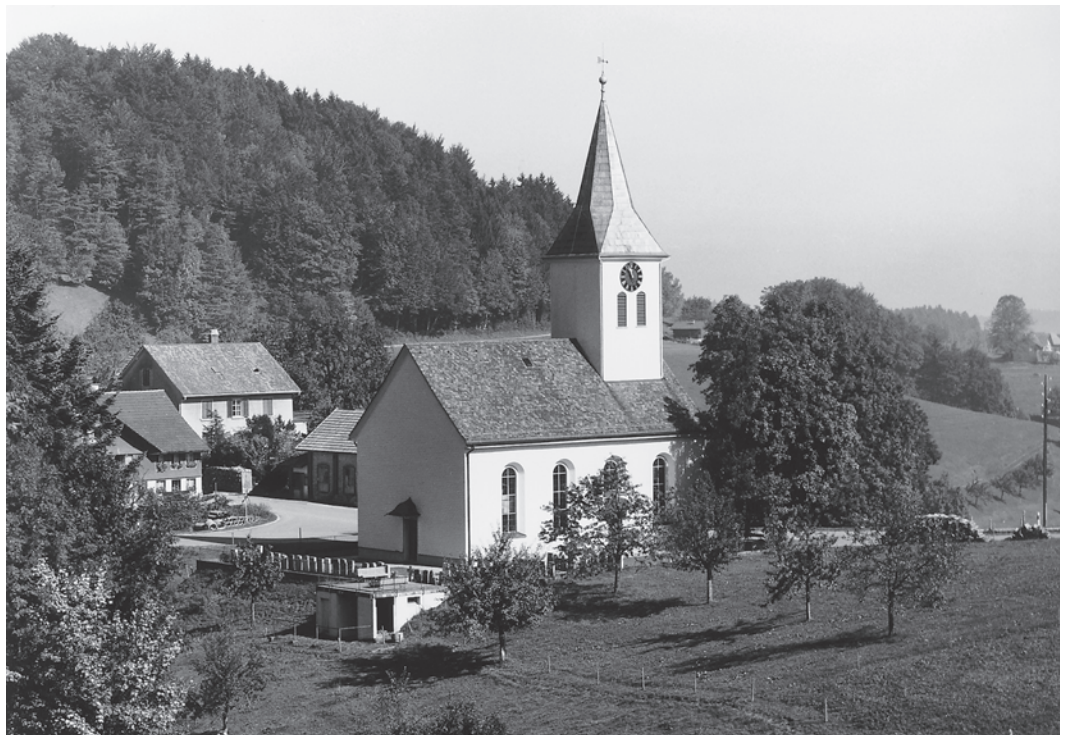
Gesamtansicht von Südwesten vor der Renovation. Zustand Oktober 1976. Fotoarchiv HBA.
