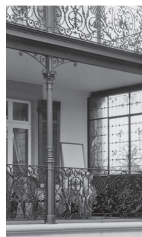
Teilansicht der doppelgeschossigen Veranda mit Gusseisenstützen und -brüstungen an der Ostfassade. Zustand nach der Aussenrenovation, April 2004. Fotoarchiv HBA.
