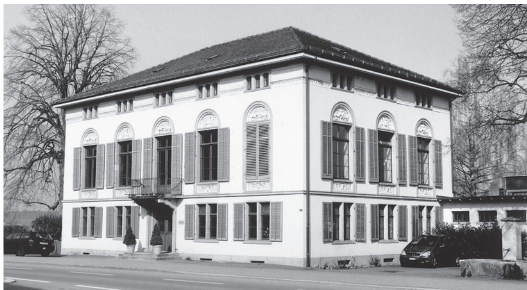
Gesamtansicht von Osten. Die Rechteckfenster am Obergeschoss weisen auf den Festsaal im Innern hin. Zustand 2005. Fotoarchiv HBA.
