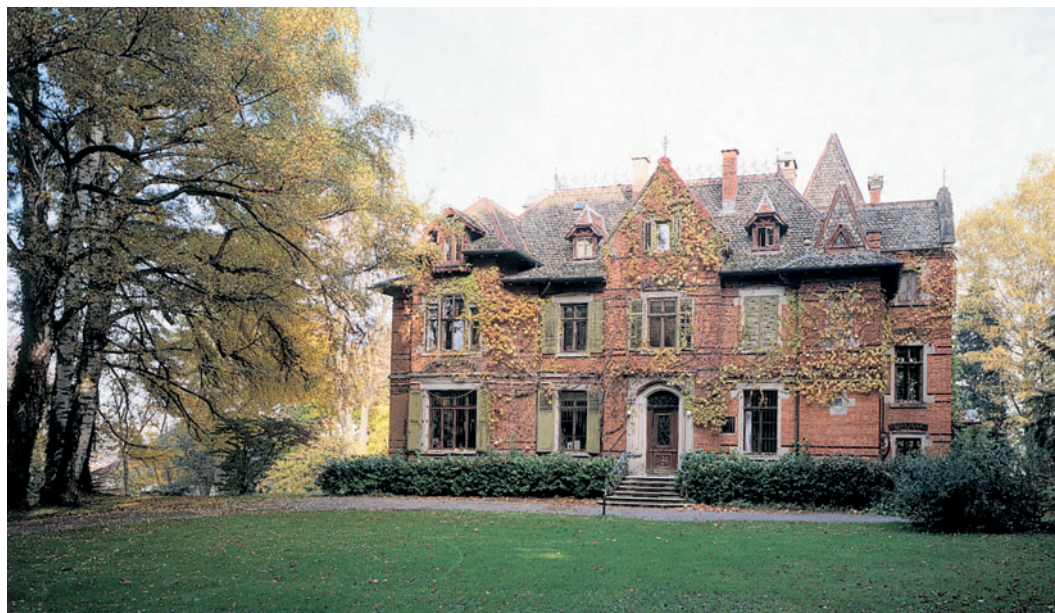
Gesamtansicht von Westen mit Umgebung. Zustand vor der Restaurierung, Oktober 2000. Fotoarchiv HBA.
