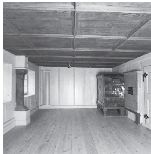
Stube im Erdgeschoss. Links: Zustand vor der Gesamtrenovation mit überstrichener Fenstersäule sowie Felderdecke, September 2000. Rechts: Zustand nach der Entfernung der Zwischenwand zur Nebenküche und der Farbanstriche, Mai 2002. Fotoarchiv HBA.
