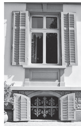
Sorgfältig restauriertes, originales Fenster mit Kastenkonstruktion. Aufnahme April 2003. Fotoarchiv HBA.
