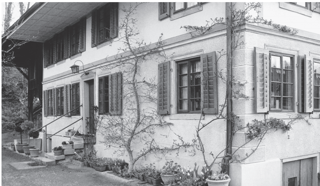
Teilansicht von Südwesten nach der Aussenrestaurierung mit den differenziert behandelten Putzpartien am Erd- und Obergeschoss der Süd- und Westfassade. Zustand April 2005. Fotoarchiv HBA.
