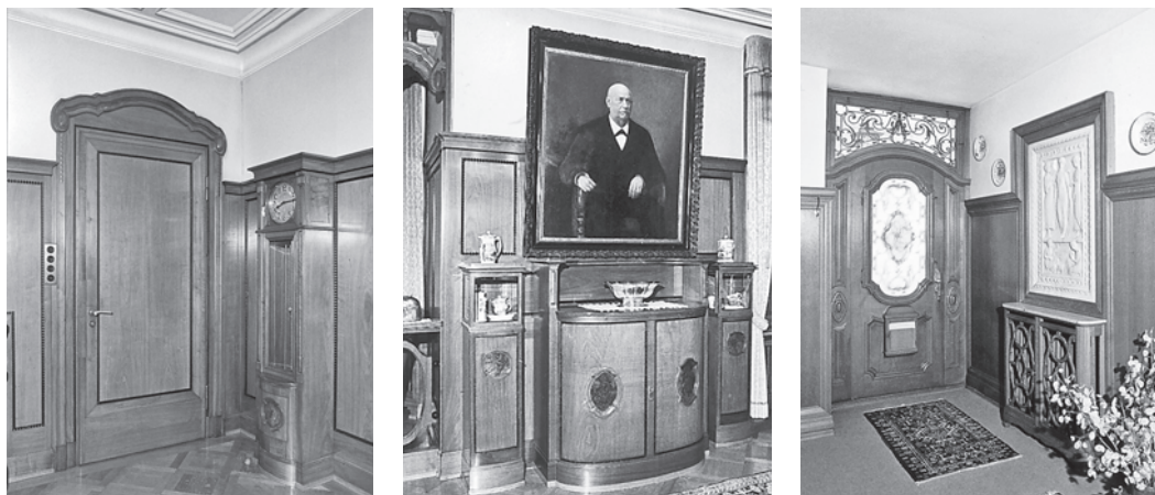
Links und Mitte: Teilansichten der Stubenausstattung von hoher handwerklicher Qualität. Zustand August 1975. Rechts: Korridor mit aufwendig gestalteter Haustür sowie Wandrelief aus weissem Marmor. Zustand August 1975. Fotoarchiv HBA.
