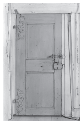
Kammertüre mit barocken Türbändern im 1. Obergeschoss (Raum 1.15). Zustand Januar 2001. Fotoarchiv HBA.
