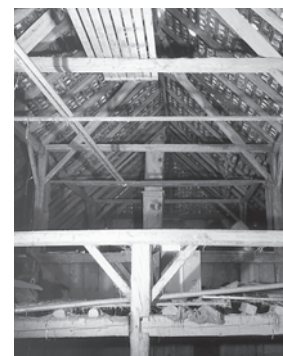
Teilsicht des Dachwerks vom Heuraum her gesehen. Blick gegen die ursprüngliche Pfetten-Rafen-Dachkonstruktion mit stehendem Stuhl über dem Wohnteil und Garbenraum. Zustand Juli 2001. Fotoarchiv HBA.
