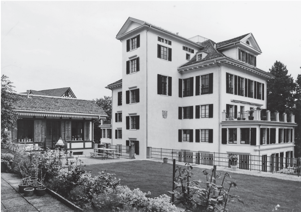
Ansicht des Haupt- und des Nebengebäudes von Süden. Zustand nach der Gesamtrenovation der beiden Bauten, Mai 2002. Fotoarchiv HBA.
