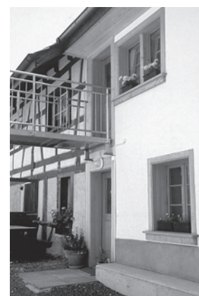
Der Laufsteg aus Metall verbindet neu das nördlich gelegene Nachbarhaus mit dem Obergeschoss. Zustand 2002. Fotoarchiv HBA.
