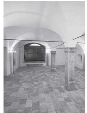
Keller 0.10. Zustand nach der Renovation, April 2002. Fotoarchiv HBA.
