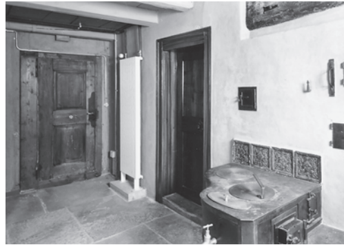
Links: Teilansicht der Stube 0.08 mit der neu eingepassten Fenstersäule und der von der Vertäferung befreiten Bohlen-Balkendecke. Zustand März 2001. Rechts: Küche 0.06/0.07 mit Feuerwand und neu eingebautem Eisenherd. Zustand März 2001. Fotoarchiv HBA.
