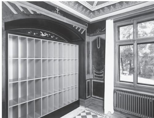
Ehem. Badezimmer im 1. Obergeschoss. Links: Zustand vor der Restaurierung mit den Sondieröffnungen des Restaurators, September 2000. Rechts: Zustand nach der Freilegung bzw. Restaurierung der Fassung von 1888, März 2002. Fotoarchiv HBA.
