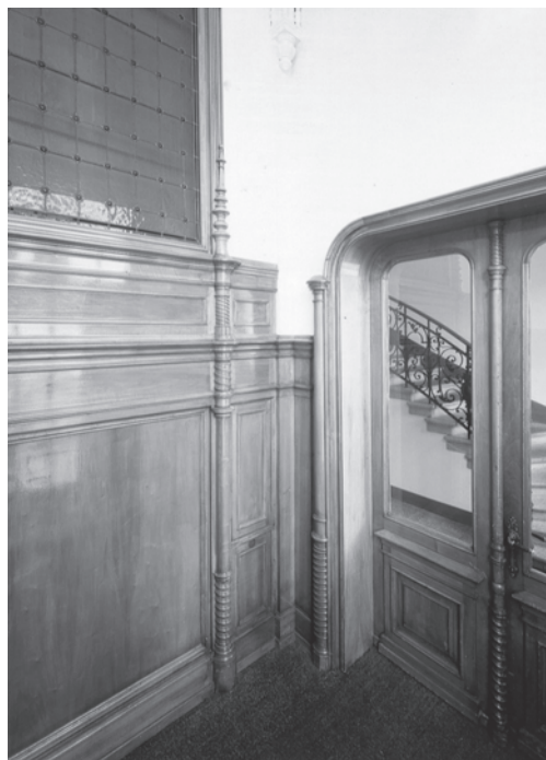
Wohn- und Geschäftshaus Beethovenstrasse 7. Links: Die noch aus der Bauzeit stammende Kabine des Personen-Aufzugs nach der Restaurierung. Zustand Oktober 2004. Rechts: Treppeneingang. Der Lift befindet sich weiter oben. Zustand Oktober 2004. Fotoarchiv HBA.
