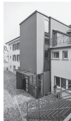
Teilansicht der Nordfassade mit dem neuerrichteten Treppenhauseinbau. Zustand August 2003. Fotoarchiv HBA.
