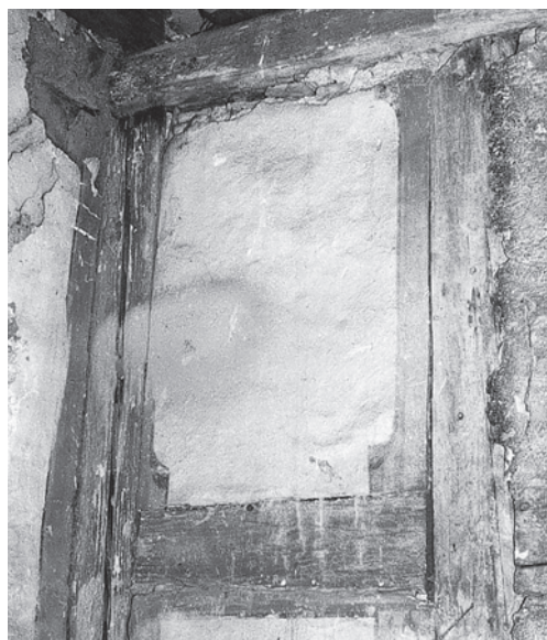
Links: Barocke Rankenmalerei an der Decke im ehemaligen Hauskorridor (heute Teil des Raums 0.05). Zustand März 2001, vor der Zerstörung. Rechts: Farbige gefasste Sichtfachwerkwand von 1676 im Raum 2.08. Zustand November 2001, vor der Zerstörung. Fotoarchiv HBA.
