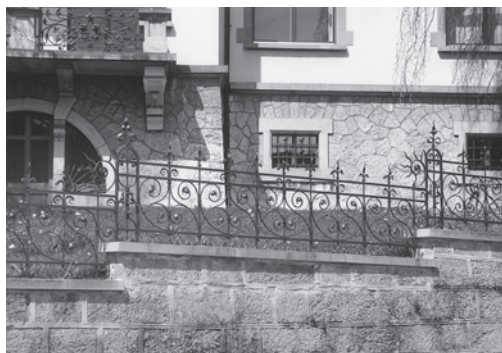
Links: Rüti, Wohn- und Gewerbegebäude, ehem. Postgebäude Vers. Nr. 727, Bahnhofstrasse 8. Nach Aussenrenovation, Aufnahme 2004.
