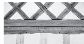
Die eingekerbte Inschrift am Balken an der Südfassade lautet «17 * FAB* ASMB*ZB*HSAS*R*ZFB* HHWM*ZIM * 90». Sie ist bisher nicht aufgeschlüsselt worden. Zustand Februar 2004. Fotoarchiv HBA.
