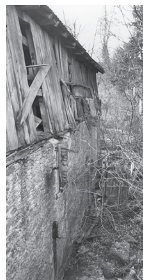
Teilansicht der Nordwestfassade im Bereich des früher bestehenden, überschlächtigen Wasserrades. Zustand März 1995. Fotoarchiv HBA.
