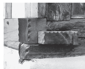
Das erneuerte Schwellenschloss an der südöstlichen Gebäudeecke. Zustand Februar 2004. Fotoarchiv HBA.
