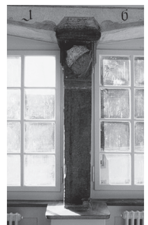
Sandsteinerner Fensterpfeiler mit Zürcher-Wappen in der ehemaligen Schulstube (1.2) im 1. Obergeschoss. Zustand nach der Restaurierung, Oktober 2001. Fotoarchiv HBA.
