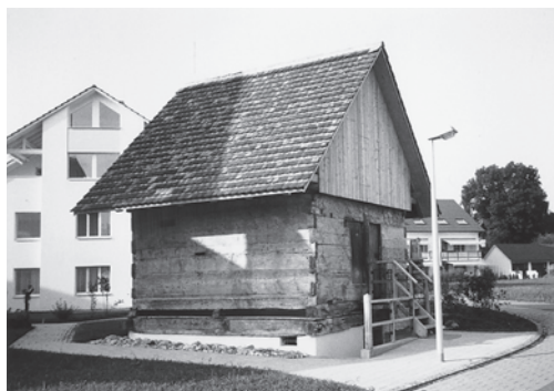
Links: Uster, ref. Kirche Vers. Nr. 2330, Kirchuster, Zentralstrasse. Nach Aussenrenovation, Aufnahme 2002.
