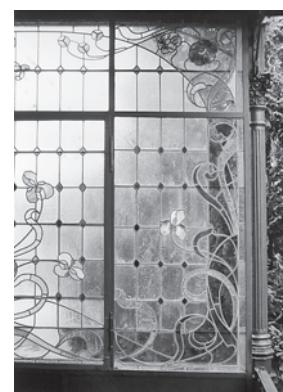
Ausschnitt der Farbverglasung mit Jugendstilornamentik von 1903 an der Nordseite der Veranda. Zustand nach der Aussenrenovation, April 2004. Fotoarchiv HBA.
