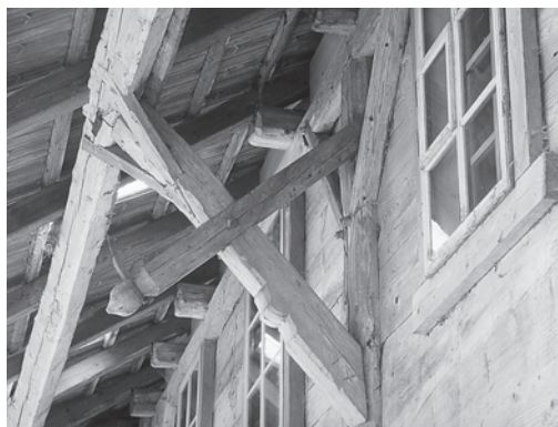
Links: Ehemaliger Bienenstand im giebelseitigen Anbau vor dem Abbruch. Zustand Juni 2001. Rechts: Detail der nordseitigen Vordachkonstruktion nach der Renovation. Zustand April 2003. Fotoarchiv HBA.
