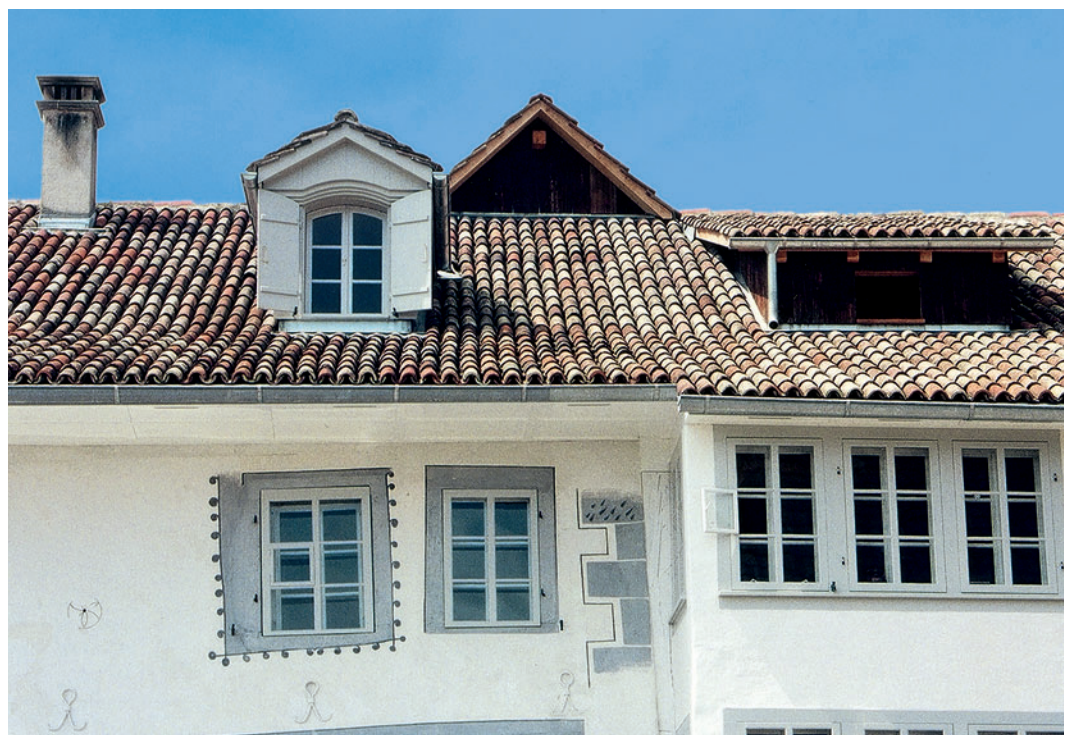
Rechts: Teilansicht der Ostfassade mit restaurierten Fenstern, Resten der früheren Fassadenfassung, redimensionierter Giebel-lukarne und wiederhergestellter Hohlziegelein-deckung. Zustand März 2001. Privataufnahme.
