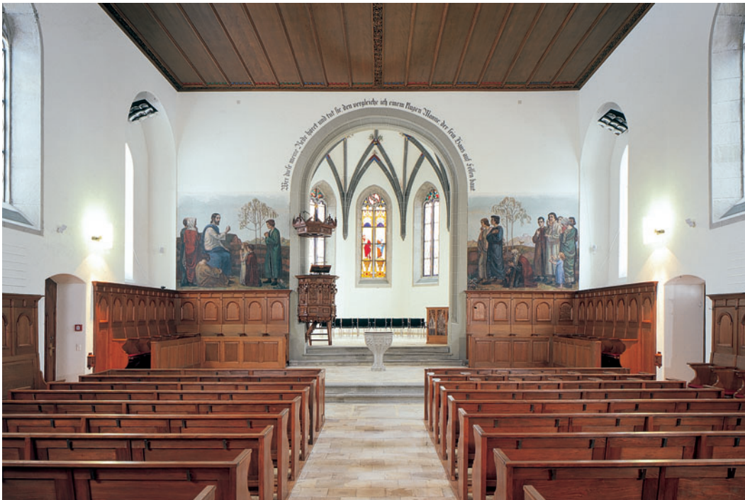
Inneres gegen den Chor. Zustand nach der Restaurierung, Februar 2003. Fotoarchiv HBA.
