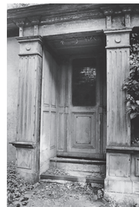
Teilansicht der Ladenfront mit Eingang. Zustand vor der Instandstellung der Gebäudehülle, August 1999. Fotoarchiv HBA.
