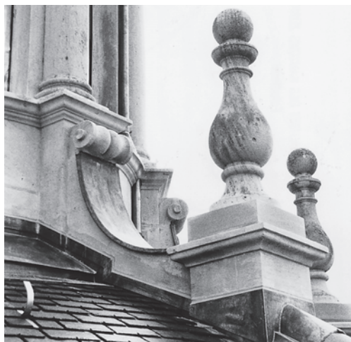
Links: Kupferblechverkleidete Volute an der Kuppel. Zustand nach der Neueindeckung des Kuppeldaches mit Schiefer bzw. der Reparatur der Blechabdeckung, Mai 2002.
