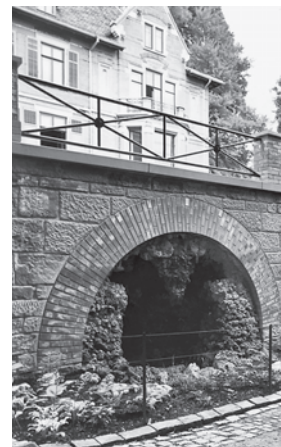
Stützmauer und Grotten-Nische nach der Instandstellung. Zustand Juni 2002. Fotoarchiv HBA.
