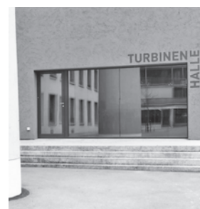
Neugestaltete Eingangssituation zur Turbinenhalle beim Hochkamin. Zustand April 2005. Fotoarchiv HBA.
