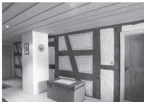
Links: Küche 0.05 nach der Restaurierung mit neu eingebautem Tonplattenboden, Deckentäfer und Holzherd. Zustand 2002. Rechts: Gang 1.01 nach der Restaurierung, mit der ergänzten Farbfassung. Zustand 2002. Fotoarchiv HBA.
