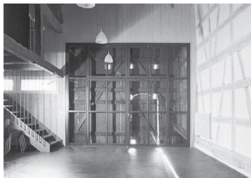
Links: Verglastes Tenntor an der Südwestfassade. Zustand nach der Renovation, Februar 2002. Rechts: Versammlungsraum im Erdgeschoss. Zustand nach der Umnutzung, Februar 2002. Fotoarchiv HBA.
