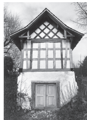
Gesamtansicht von Süden. Der Fachwerkbau über gemauertem Kellergeschoss besitzt Eichenschwellen mit Schwellenschlössern, geknickte Büge sowie ein Sparrendach mit Aufschieblingen und Flugsparrenkonstruktionen. Zustand Februar 2004. Fotoarchiv HBA.
