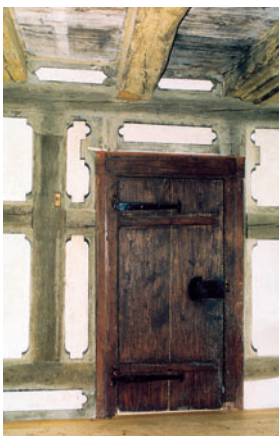
Ausschnitt der farbig gefassten Fachwerkwand im Raum 1.7. Zustand nach der Freilegung und Restaurierung, Juni 2002. Fotoarchiv HBA.
