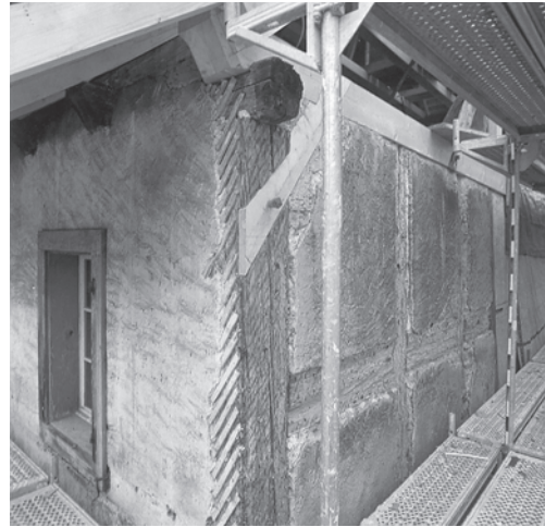
Links: Nordöstliche Gebäudeecke im Bereich des 1. Obergeschosses. Ehemaliger Eckständer von 1570d mit ergänzten Fusshölzern; im Vordergrund der aktuelle Eckständer von 1886. Zustand während der Instandstellung, März 2001. Rechts: Südöstlicher Eckständer von 1570d mit ergänztem Kopfholz im Bereich des 1. Obergeschosses. Zustand während der Instandstellung, Mai 2001. Fotoarchiv HBA.
