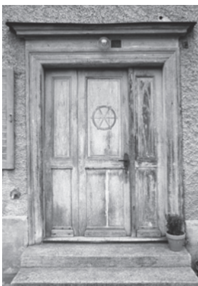
Eingangstüre zum Wohn- und ehemaligen Mühlegebäude vor der Renovation. Zustand April 2001. Fotoarchiv HBA.
