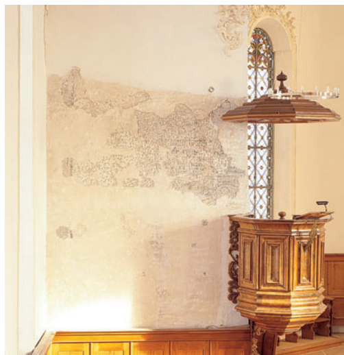
Links: Stuckdecke im Chor. Zustand nach der Restaurierung, Mai 2002. Rechts: Während der Bauarbeiten kamen an der westlichen Turmwand eine barocke Rollwerkmalerei sowie ein unlesbarer Wandspruch zum Vorschein. Sie gehörten zur Ausschmückung der 1758 abgebrochenen Vorgängerkirche. Zustand Januar 2002. Fotoarchiv HBA.
