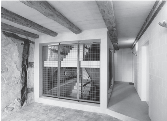
Oben links: Hauseingang und neues Betontreppenhäus. Links ein Ständer der zum Nachbargebäude gehörenden Fachwerkwand aus der Zeit um 1360 mit leeren Blattsassen. Zustand nach dem Umbau, 2002. Oben rechts: Gang 1.1 mit restaurierter Deckenmalerei und wiederverwendetem Geländer der alten Treppe. Zustand nach dem Umbau, 2002. Fotoarchiv HBA.
