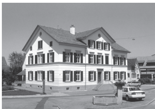
Links: Birmensdorf, Wohnhaus, ehem. Bauernwohnhaus Vers. Nr. 6, Filderen, Luzernerstrasse. Renovation in Etappen 1999–2002, Aufnahme 2004.
