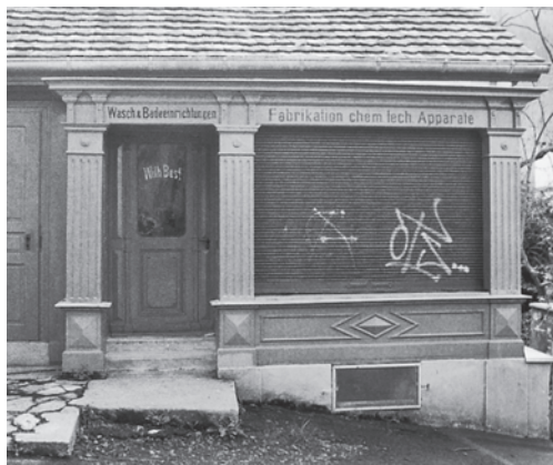
Links: Nordostfassade nach Abbruch der nachträglichen Anbauten und der Instandstellung der Gebäudehülle. Zustand April 2005. Rechts: Ladenfront mit Eingang nach der Instandstellung bzw. Restaurierung. Zustand April 2005. Fotoarchiv HBA.
