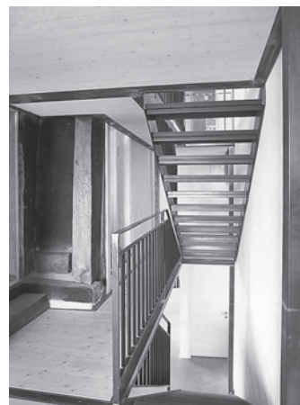
Hausteil Vers. Nr. 444. Innenansichten nach der Renovation, Zustand April 2003. Links: Teilansicht der Stube 0.02 mit neuem Bretterboden und Kachelofen. Mitte: Blick aus der Kammer 1.02/1.03 gegen das neue Treppenhaus. Rechts: Korridor 1.01 im 1. Obergeschoss. Neu sind die tragende Metallkonstruktion und die Treppenanlage. Fotoarchiv HBA.
