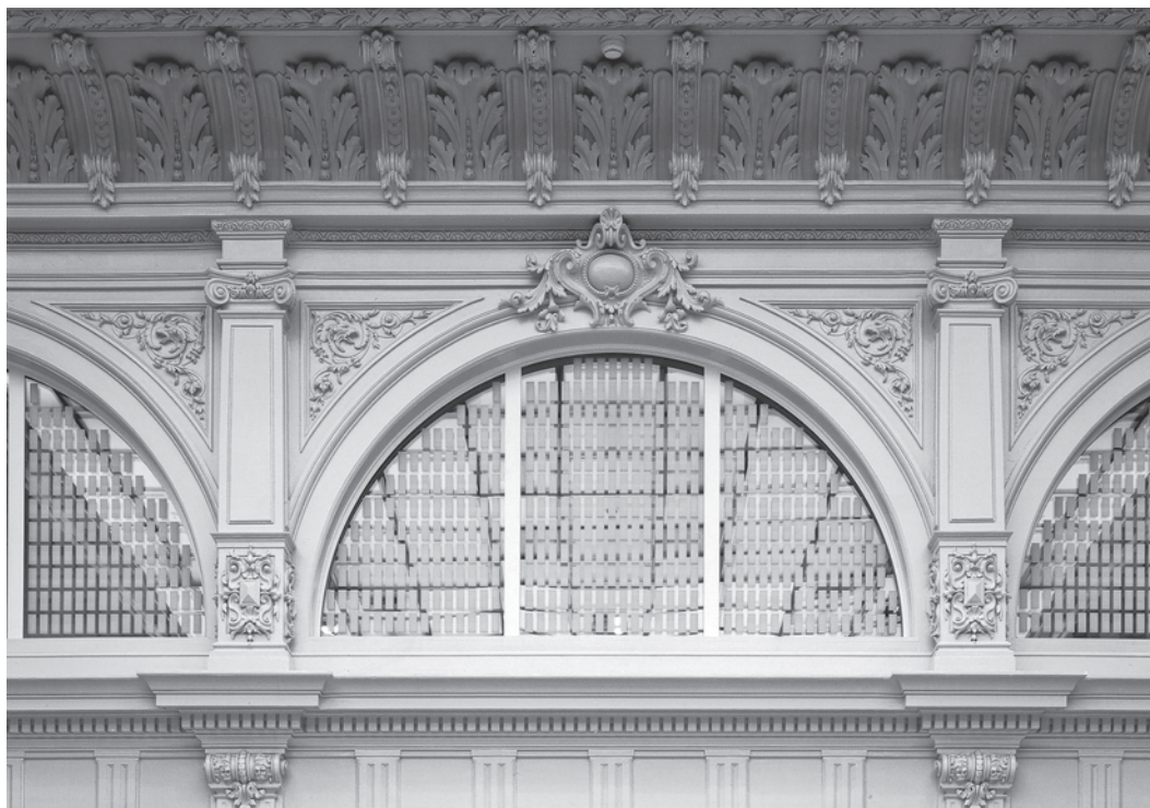
Wandausschnitt des Lichthofs (grosse Halle) nach Umbau und Renovation. Die Stuckteile wurden freigelegt, repariert und die Fehlstellen ergänzt. Nach einer Vorretusche der Fehl- und Reparaturstellen wurde der Stuck einheitlich hellgrau gefasst. Zustand September 2004. Fotoarchiv HBA.
