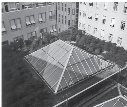
Links: Kleinere Halle des neuen Lichthofs mit Blick Richtung Paradeplatz. Links im Bild ist ein Teil des erhaltenen, originalen Ladenfensters zu sehen. Zustand September 2005. Rechts: Blick vom 4. Ober- geschoss hinunter in den Innenhof. Zustand September 2005. Fotoarchiv HBA.
