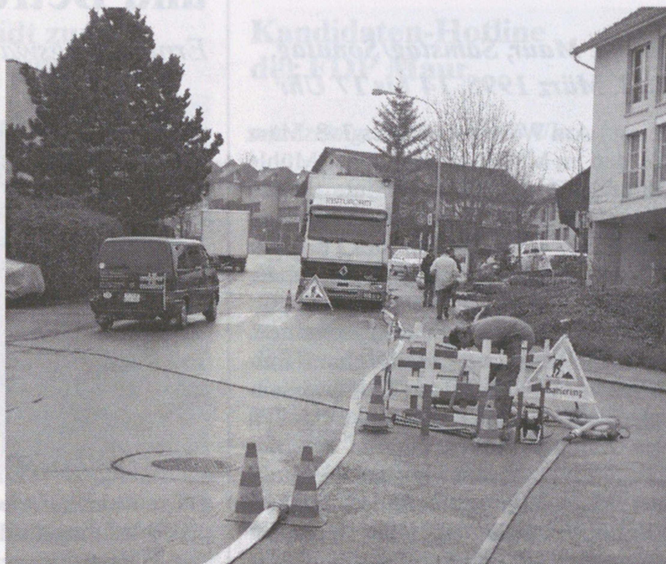
Mit der Kanalsanierung wurde bereits vorgestern begonnen. (Foto: sl)
