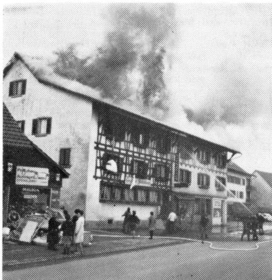
Brandausbruch Restaurant Stammbaum in Hegnau, 21. März 1968 (Cliché: Anzeiger von Uster)
