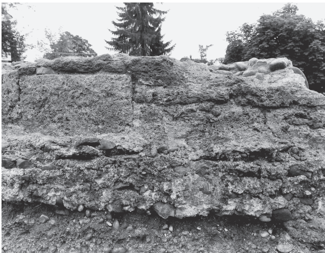
Abb. 22. Kloten. Pfarreizentrum. Phase B. Befestigungsmauer Ost (Pos. 10), Detail der Innenseite mit Mauerschale aus Tuffsteinblöcken. Blick nach Osten.
