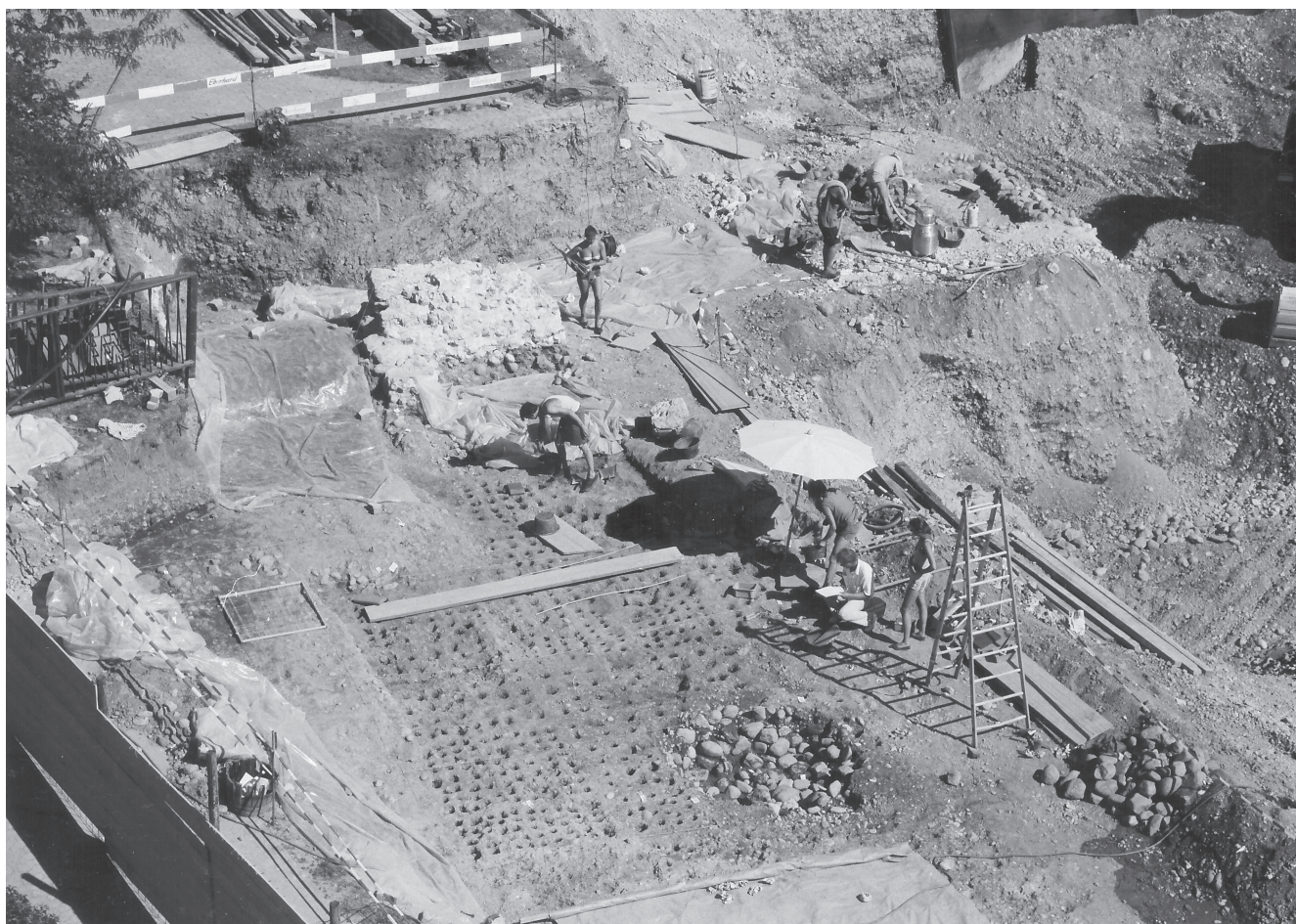
Abb. 25. Kloten. Pfarreizentrum. Phase B. Übersicht der Fundamentpfählung Torbau/Torturm. Blick nach Südosten.
