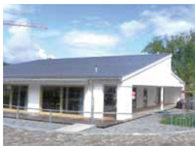
Das eingeschossige Holzgebäude formt sich sehr gut in die Umgebung ein.
