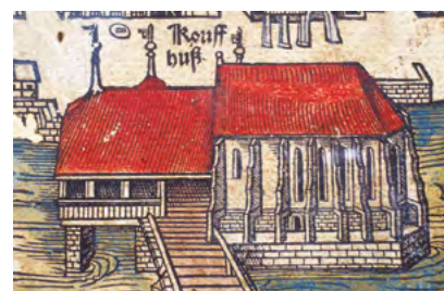
Das schützende Vordach (Helm) des Kouffhuß (ein Anbau der «Wasserkilch») wurde später zum Helmhaus.
