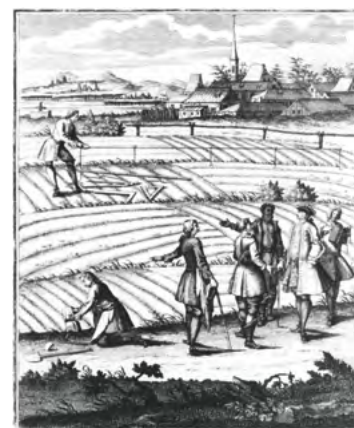
Hier vermessen die Herren einen Acker noch recht altmodisch mit Equerre, Messeil und Pflöcken und setzen einen Marchstein.
