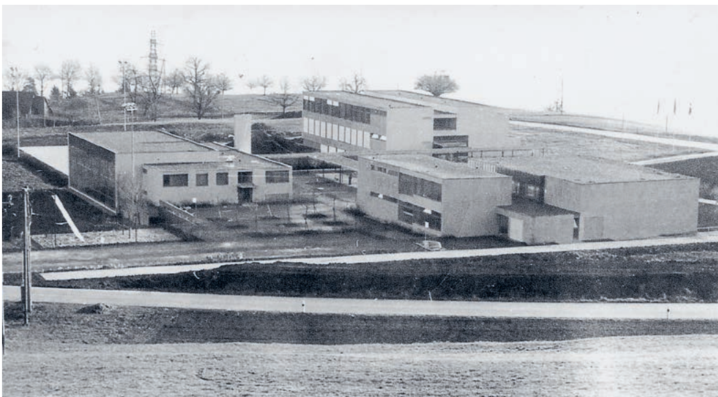
Das frisch gebaute Loorenschulhaus bei der Einweihung 1965.
