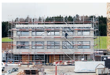
Am Schulhaus Nord sind die Betonelemente der Aussenfassade montiert.
