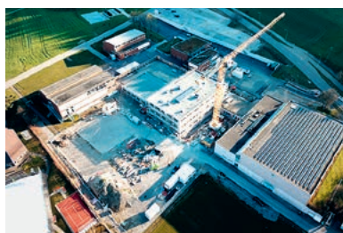
Die Loorenbaustelle aus der Vogelperspektive.
