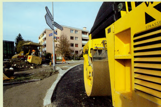
Baumaschinen auf der Brücke Süd.
