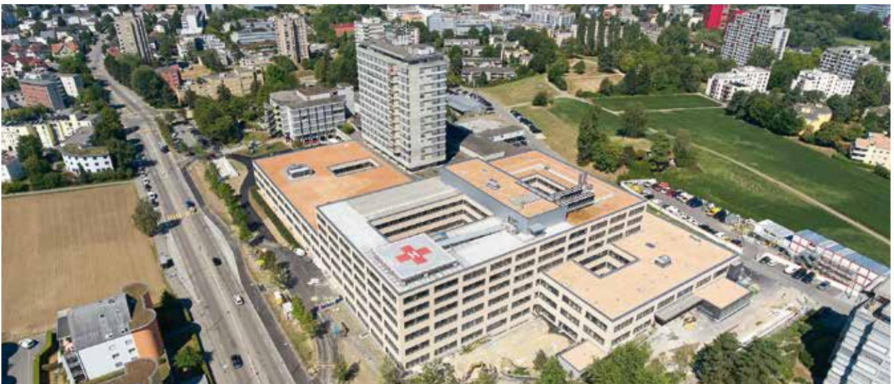
Spital Limmattal Eingang Notfall auf der Ostseite
