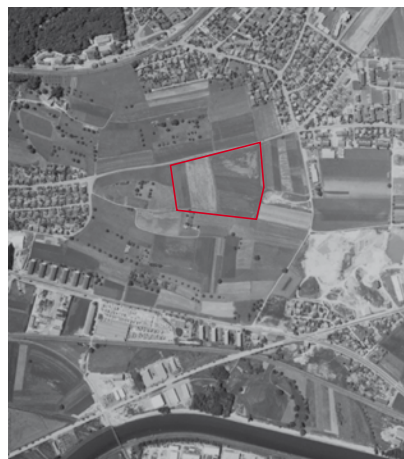
Luftaufnahme 1963 des Gebietes zwischen Schlieren und Urdorf. Unten der Limmatlauf, oben links das Bahnhofgebiet Urdorf. Im rot eingerahmten Feld wurde das Spital erstellt.
