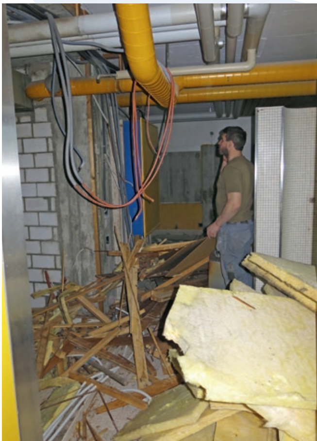
Hier werden die Anlageteile der alten Sauna abgebrochen. Unsere Saunagäste werden vom neuen Wellnessbereich begeistert sein.
