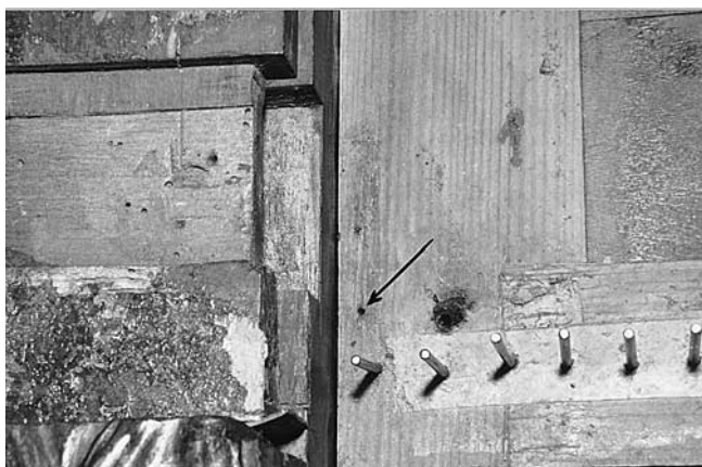
Abb. 53–54 Rheinau. Ehem. Klosterkirche. Hauptorgel. Die Klaviaturrahmen des I. Manuals nach Ausbau der Tasten, Bass- und Diskantseite. Der Rahmen liegt lose zwischen den seitlichen Klaviaturbacken und zeigt deutliche Befestigungsspuren der originalen Schiebekoppelvorrichtung.
