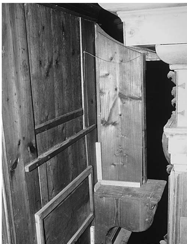
Abb. 81 Rheinau. Ehem. Klosterkirche. Hauptorgel. Rückpositiv. Die schlitzartigen Löcher der ursprünglichen Registermechanik in den beiden äussersten Friesen der Rückpositivwand wurden wohl schon 1756 mit passenden Furnieren überdeckt. Die Fugen der Flicke sind nur aus nächster Nähe erkennbar.
