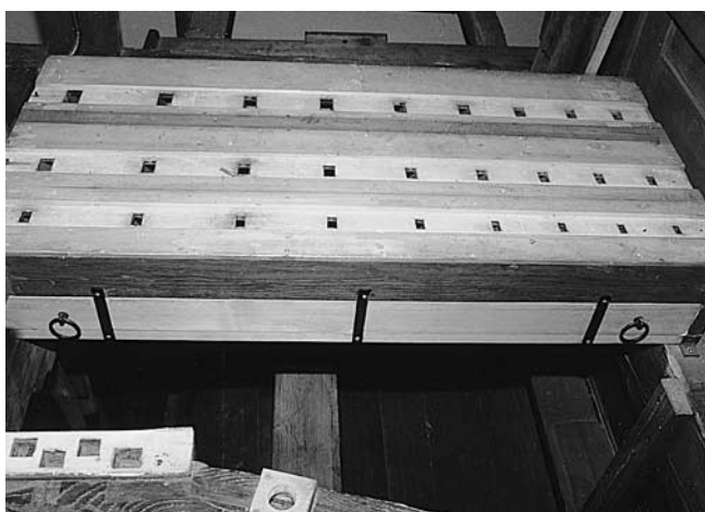
Abb. 46 Rheinau. Ehem. Klosterkirche. Hauptorgel. Die Zusatz-Pedalladen für drei Register weisen eine andere Machart auf als die originalen Leu-Windladen; sie dürften auf die Erweiterung von 1756 zurückgehen und wurden jetzt eliminiert. C-Lade mit ausgebauten Stöcken und Schleifen.
