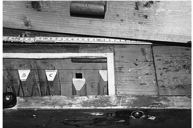
Abb. 42–43 Rheinau. Ehem. Klosterkirche. Hauptorgel. Links: Rückpositivwindlade mit aufgekippten Pfeifenstöcken. Oben orig. Prospektstock (Nussbaum) mit eingestimmten, sauber verspundeten Verführungen. Darunter neuer Stock (Eiche) von Haas mit Zusatzbohrungen im Fundament für Zusatzventile. Rechts: Zwei der von Haas eingebauten Zusatzventile im Rückpositiv. In diesem Bereich ist der Steg des Windkastens nachgeschnitten. Die Zusatzventile tragen, im Gegensatz zu den funktionellen Ventilen, auf der Stirnseite keine Tonbezeichnungen.
