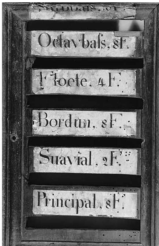
Abb. 115–118 Rheinau. Ehem. Klosterkirche. Chororgel. Originale linke und rechte Registerstafeln im ausgebauten Zustand 1962. Oben: Vor dem Ablösen der Haas'schen Überklebungen. Unten: Nach der Freilegung der Originalbeschriftung von Speisegger.
