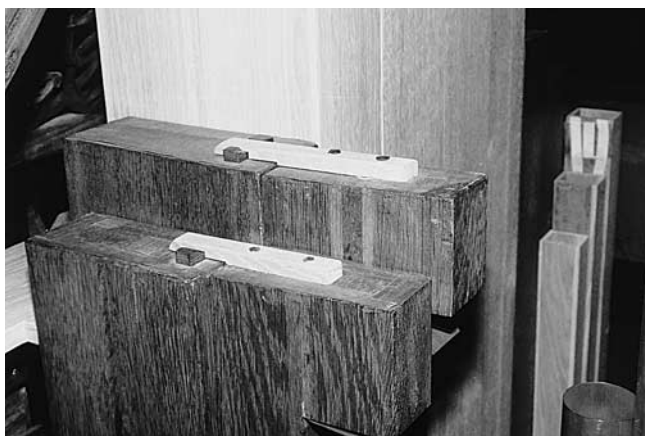
Abb. 121–122 Rheinau. Ehem. Klosterkirche. Chororgel. Oben: Reste der originalen Pfeifenanhangung der tiefen Pfeifen von Principal 8'. Unten: Anhand der Spuren rekonstruierte Pfeifenanhangung.
