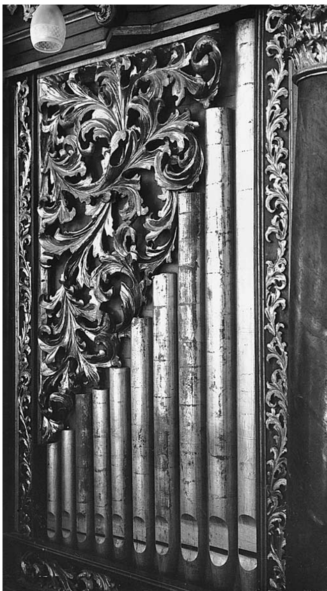
Abb. 86–87 Rheinau. Ehem. Klosterkirche. Hauptorgel. Blinder «Brustwerkprospekt» von Haas aus dem Jahr 1841 rechts seitlich des Spieltisches. Links: Die Pfeifen sind halbrunde, mit Silberpapier belegte Holzattrappen. Deutlich erkennbar sind die Ansatzstellen der einzelnen Papierstreifen. In derselben Art wurden von Haas auch die insgesamt acht blinden Pfeifen des Hauptprospektes neu gefertigt. Historische Aufnahme von 1929. Oben: Zustand nach der Restaurierung 1988–1990. Aufnahme von 1998.
