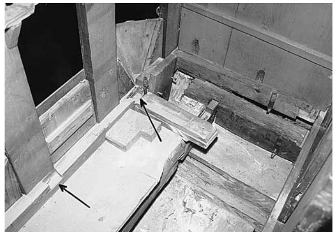
Abb. 78–79 Rheinau. Ehem. Klosterkirche. Hauptorgel. Rückpositiv. Links: Der Grundrahmen des Gehäuses wurde durch Einschnitte geschwächt und kippte nach vorne. Rechts: Im prospektseitigen Stück des Grundrahmens sind noch die Ausschnitte für die originalen Windladenlager zu sehen.
