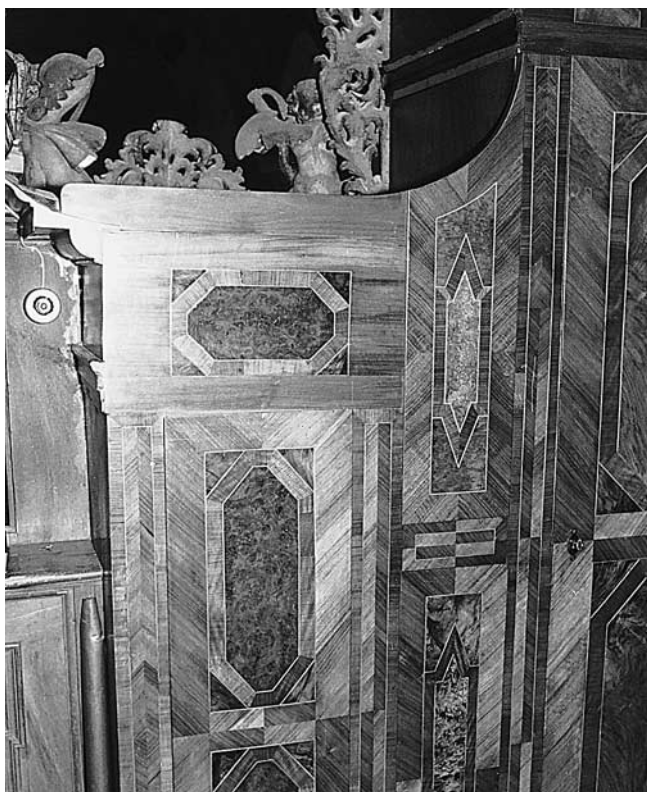
Abb. 81 Rheinau. Ehem. Klosterkirche. Hauptorgel. Rückpositiv. Die schlitzartigen Löcher der ursprünglichen Registermechanik in den beiden äussersten Friesen der Rückpositivwand wurden wohl schon 1756 mit passenden Furnieren überdeckt. Die Fugen der Flicke sind nur aus nächster Nähe erkennbar.
