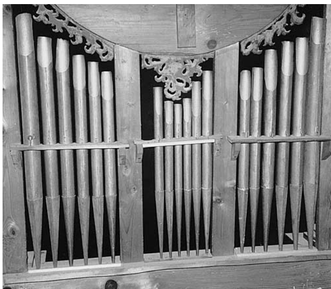
Abb. 84 Rheinau. Ehem. Klosterkirche. Hauptorgel. Mittelteil des blinden Oberwerkprospekts. Innenansicht vor der Restaurierung. Die Pfeifen sind am oberen Ende ausgeschnitten.
