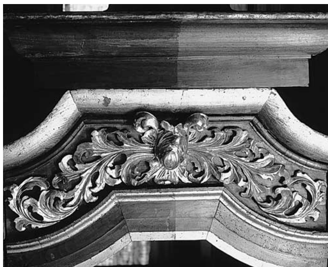
Abb. 91 Rheinau. Ehem. Klosterkirche. Hauptorgel. Fries über dem rechten Diskantfeld. Links vor, rechts nach Firnisabnahme.
