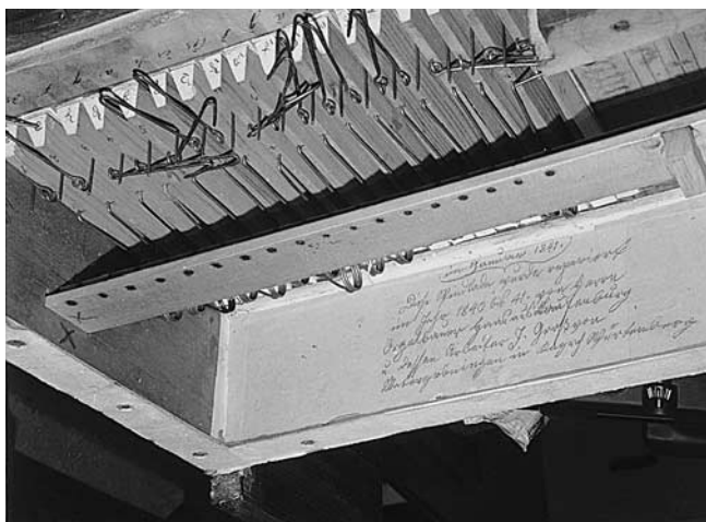
Abb. 40–41 Rheinau. Ehem. Klosterkirche. Hauptorgel. Oben: Ausgebaute Windlade des Rückpositivs vor der Restaurierung; Reparaturinschrift von Haas 1840/1841. Unten: Rückpositivwindlade nach Ausbau der Ventile, Blick in die Tonkanzellen. In den zwei Kanzellen links ist die neue eichene Fundamentplatte von Haas zu sehen, in den zwei Kanzellen rechts sind noch nussbaumene Verspundungen von Leu erhalten geblieben. Originale Pergamentbespannung der Ladenunterseite mit alten Choralhandschriften.
