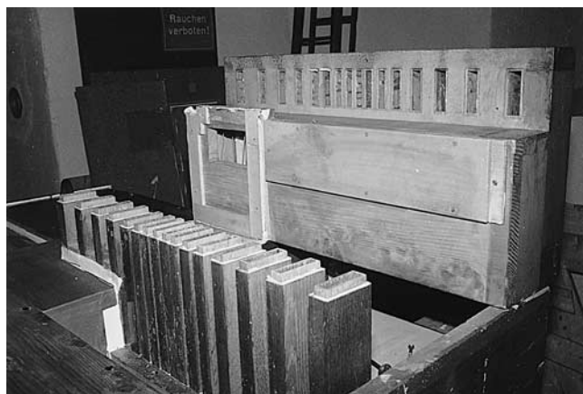
Abb. 38–39 Rheinau. Ehem. Klosterkirche. Hauptorgel. Links: Erweiterung der Windeinspeisung durch Haas; ausgebaute Hauptwerkslade umgekehrt auf Böcken lagernd. Im Bassteil links ein zweiter Ventilkasten, im Diskantenteil rechts eine Zusatzlade mit Holzkondukten zur Hauptlade. Rechts: Die Zusatzlade ist abgehoben und aufgestellt. Die Holzkondukten leiten den Zusatzwind aus der Zusatzlade in die Kanzellen der originalen Hauptlade.
