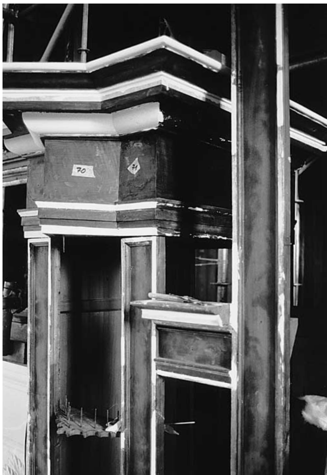
Abb. 90 Rheinau. Ehem. Klosterkirche. Hauptorgel. Fassungsarbeiten am Rückpositiv während der Restaurierung 1988–1990. Die Goldleisten sind gekittet und aufgründert.
