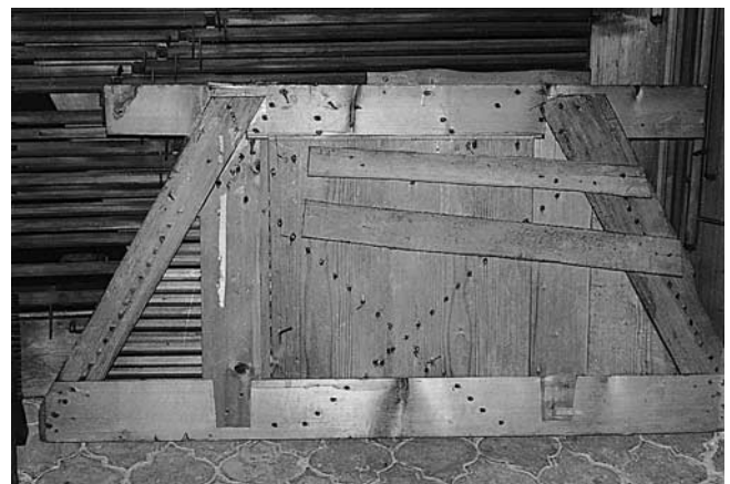
Abb. 59 Rheinau. Ehem. Klosterkirche. Hauptorgel. Ausgebautes Rückpositivwellenbrett, von der Unterseite her gesehen. Die improvisierte Wiederverwendung von Altmaterial ist deutlich sichtbar.
