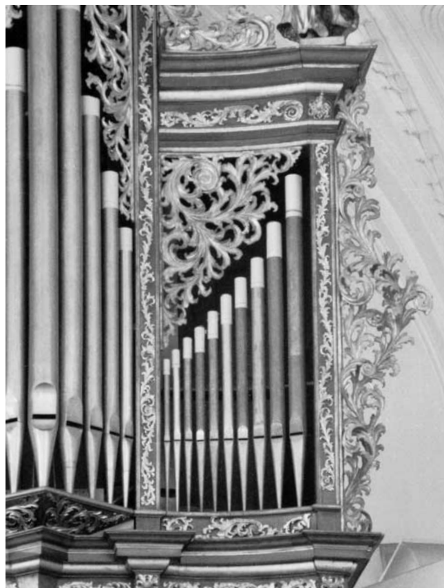
Abb. 101–104 Rheinau. Ehem. Klosterkirche. Hauptorgel. Versuche zur Ermittlung der absoluten Tonhöhe und des Temperierungssystems mittels verschiebbarer, auf die Pfeifen gesetzter Kartonverlängerungen, vor Beginn der Restaurierung. Fehlstellen bei den Schnitzereien wurden nach Möglichkeit berücksichtigt. Oben: Pedalausfelder links und rechts (Octave 8'). Unten links: Hauptwerk (Principal 8'). Unten rechts: Hauptturm rechts (Principal 16'E).
