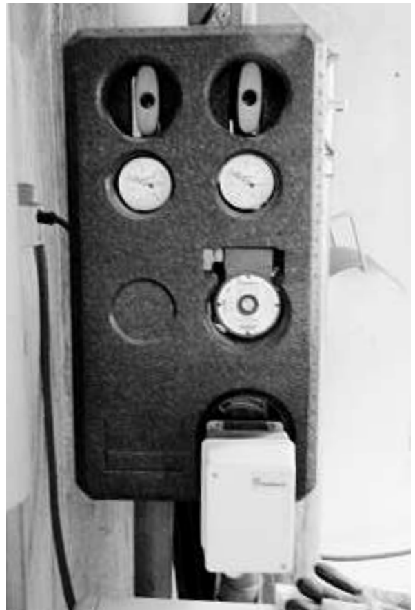
Die Schadstoffe der Ölheizung werden inskünftig von privaten Firmen auf ihre Grenzwerte hin analysiert. (Foto: cl)
