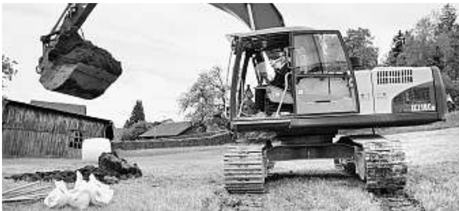
Souverän machte Peter Jäggi mit dem grossen Bagger den ersten Spatenstich
