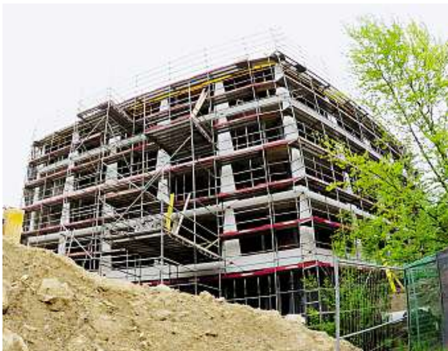
Der Neubau des Zollingerheims auf der Forch hat nun die definitive Bauhöhe erreicht.
