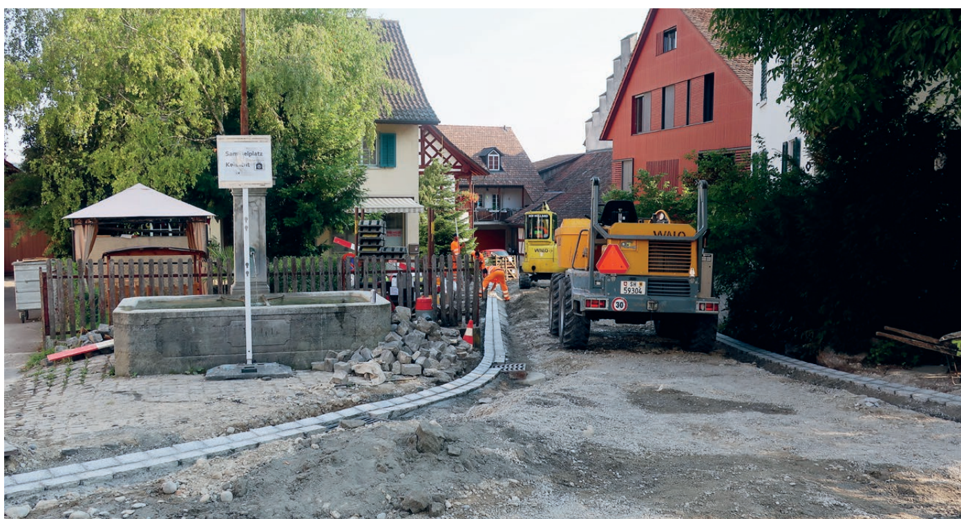
Die Bauarbeiten an der Felsenhofstrasse Mitte Juli
