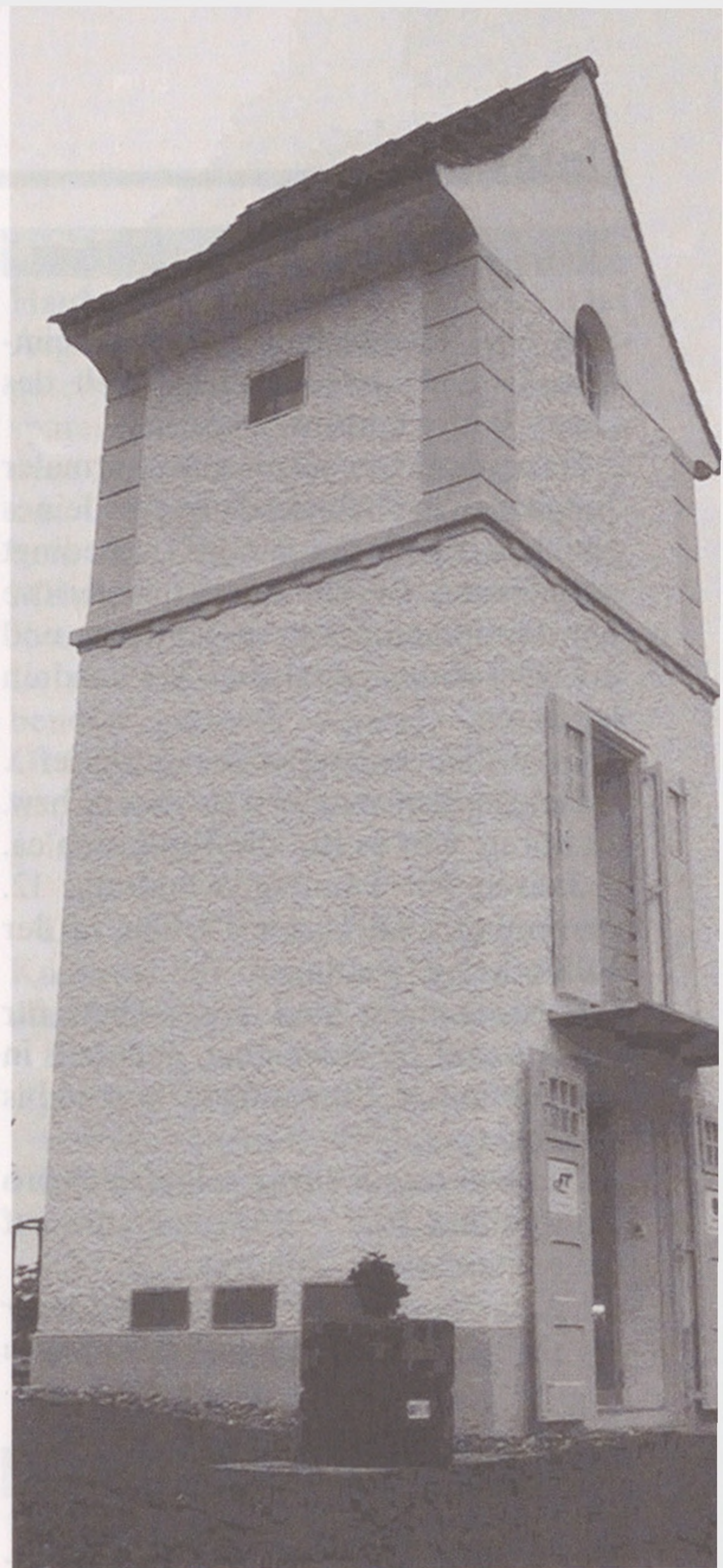
...aus der Trafostation ein Bürohaus zu machen. (Fotos: tz)
