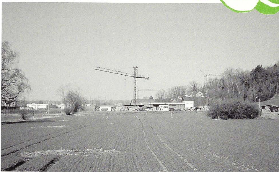
Das Gebiet, in dem heute der Blumenmarkt entsteht, könnte später zu einem Gewerbe-
