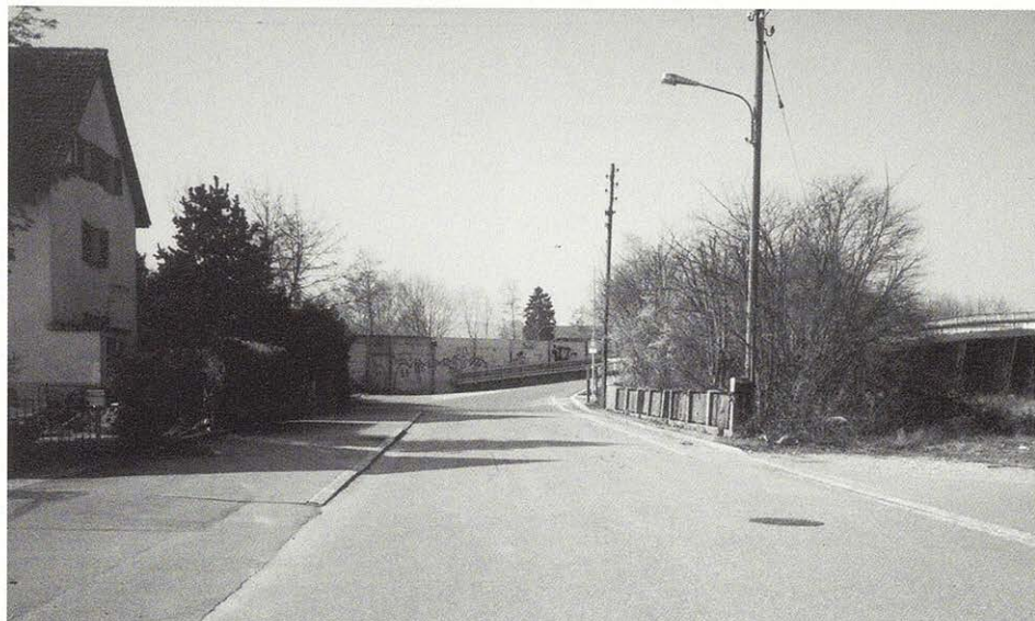
Für die Ringbahn muss an der Stelle, wo sie die A53 überquert, eine neue breite Brücke gebaut werden.
