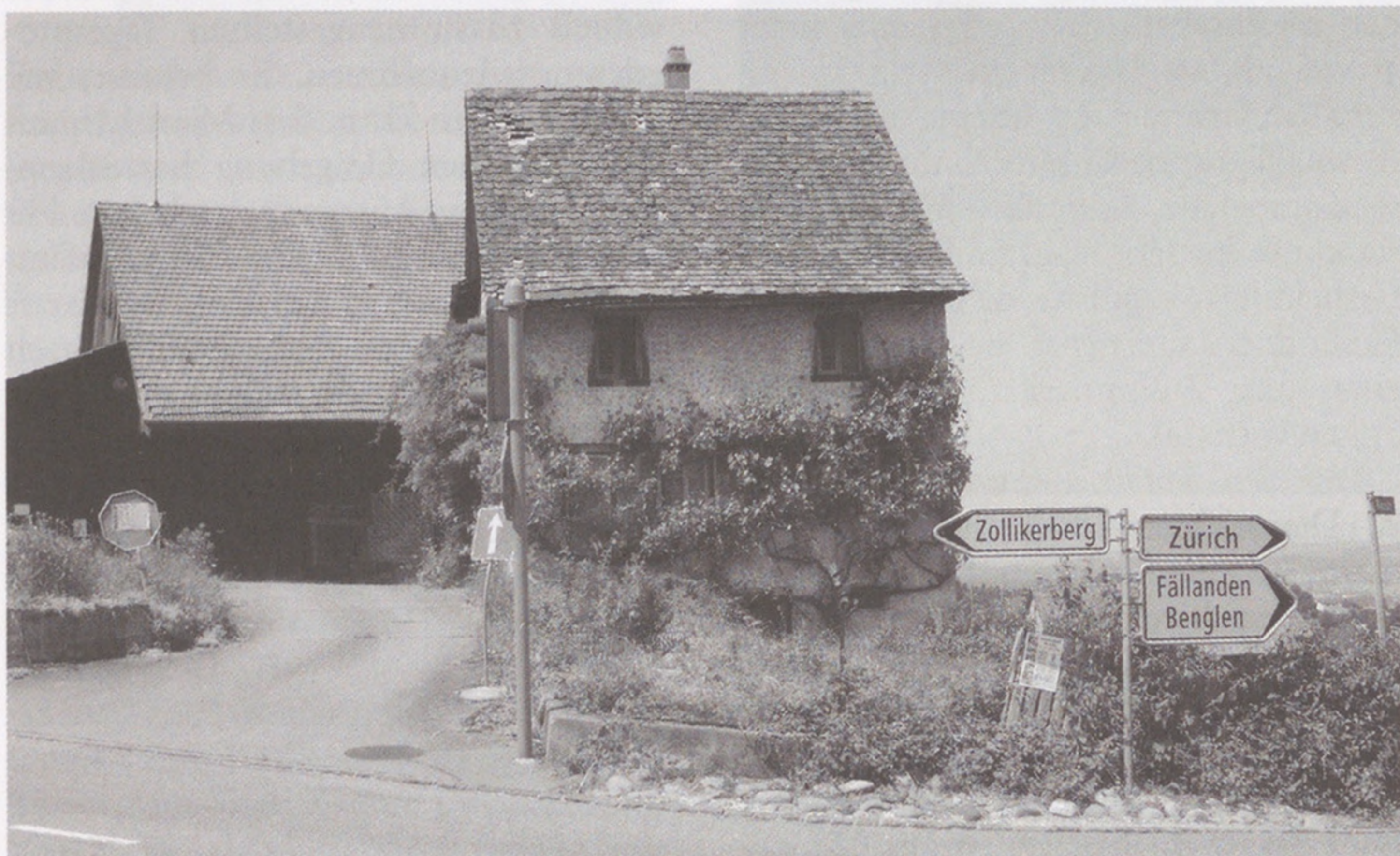
Die «unhaltbaren Zustände» mit den baufälligen Gebäuden an der Kreuzung in Binz sollen dank neuem Gestaltungsplan ein Ende haben. (Foto: fri)
