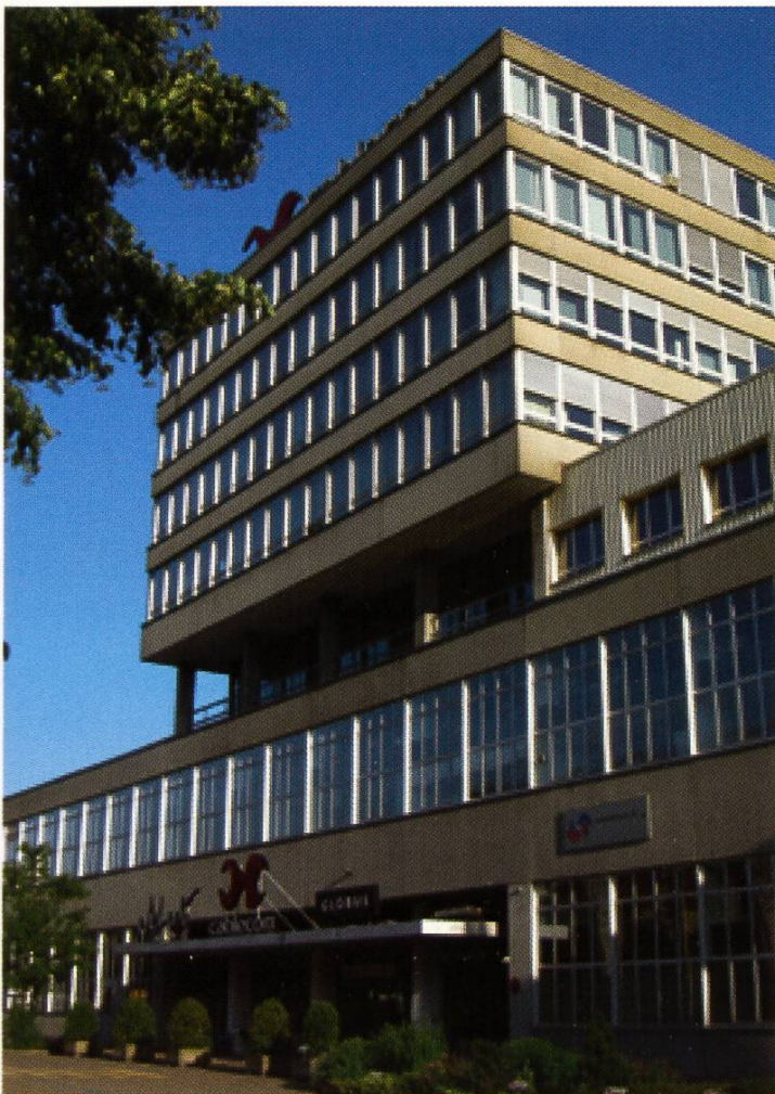
Jelmoli-Bürohaus, von Nordwesten, 2007
