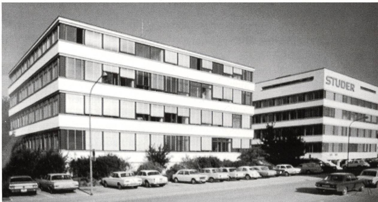
Studer Revox AG-Gebäude Althardstrasse 146 und 150, Regensdorf
