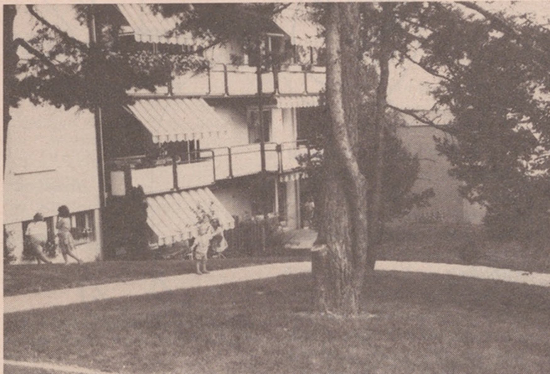
Innen und aussen wurden die Häuser der Migros Pensionskasse renoviert. Alle Wohnungen erhielten modernste Küchen und Badezimmer. Die Balkone wurden zu kleinen Terrassen ausgebaut, die Fassaden neu verputzt und auch die Grünanlagen prangen «im neuen Kleid».
