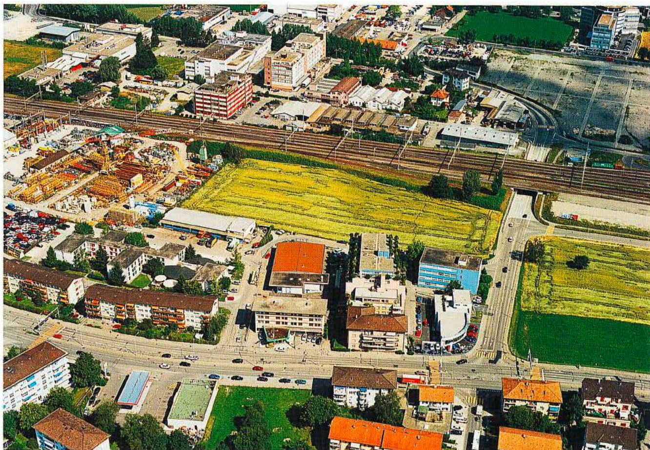
Die Südseite der Goldschlägi-Unterführung
