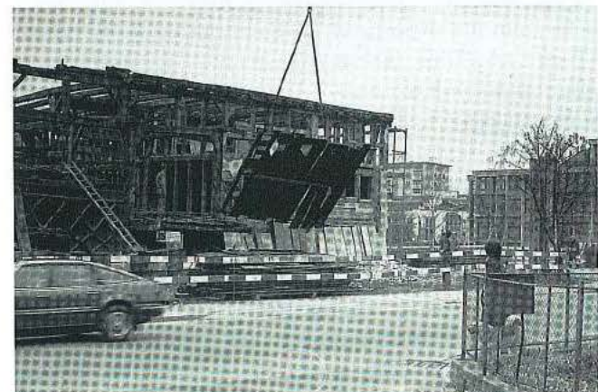
Manche Fassadenteile – hier der «Güselchratte» über dem Tenntor – wurden als Ganzes vom Haus gelöst.
