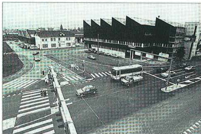
Die von Schindler mitfinanzierte neue Wagistrasse zur Erschliessung des östlichen «Wagi»-Areal, wo Krummenachers Gewerbe- und Handelszentrum Schlieren AG liegt.
