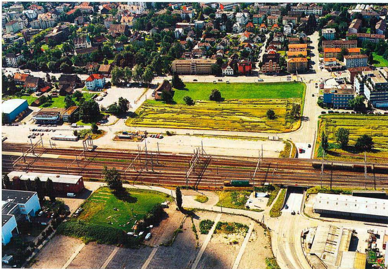
Die Goldschlägi-Unterführung aus nördlicher Richtung
