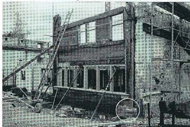
Ständerbauten sind auch für den Zimmermann nicht alltäglich. Auf der Foto finden Sie alle Teile aus der Zeichnung links unten – auch die Schwellenschlösser.
