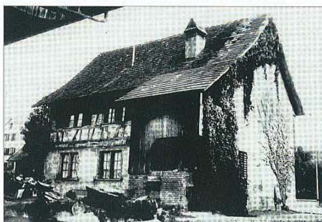
...von NW – kurz vor der Renovation von 1979
