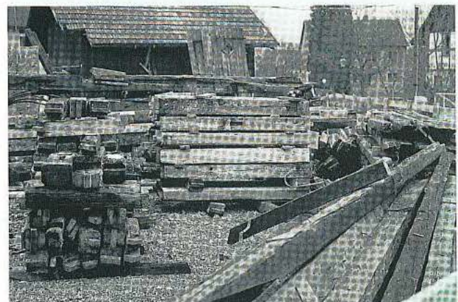
... und sortiert zur Aufbereitung gestapelt.
