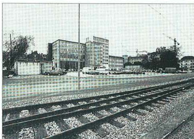
Blick über die Grabenstrasse ins Areal des Gewerbe-zentrums der Firma Ungricht und Cons.
