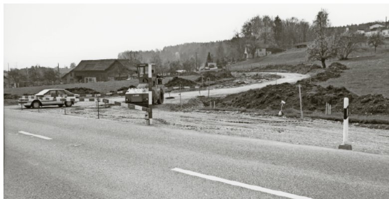
Neuerlegung der Gütschstrasse im April 1994. Im Hintergrund die Höfe Wunderli und Hummel sowie das frühere Atelier von Yvan Pestalozzi.
