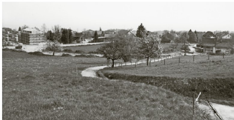
Alte Gütschstrasse im April 1994: im Hintergrund die Baustelle der Zelgli-Überbauung durch die Rentenanstalt/Swiss Life, rechts der Hof von Ernst Wunderli.
