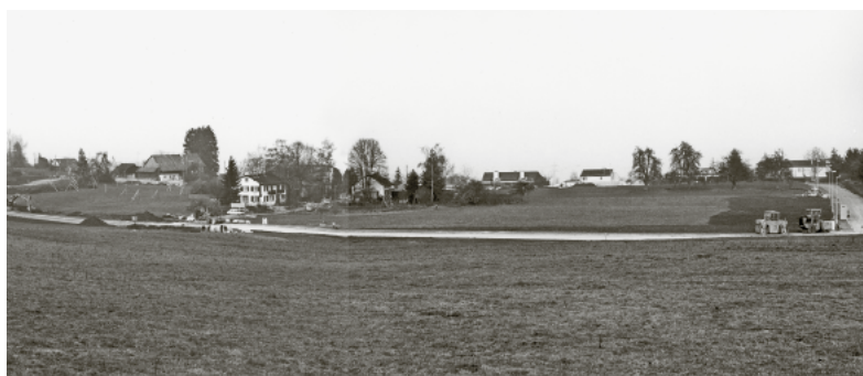
Bauzustand der Zelglistrasse am 4. Dezember 1991.
