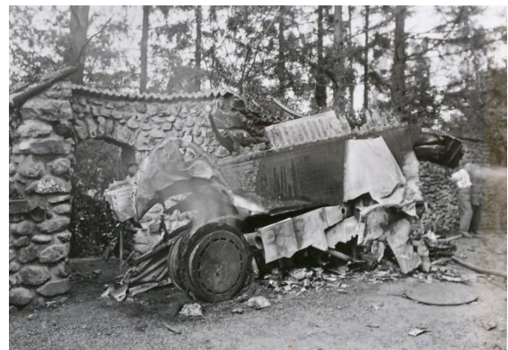
Trümmer der zerstörten Maschine lagen überall auf dem Gelände herum und wurden später verschrottet. Foto Familienarchiv Max Huber
