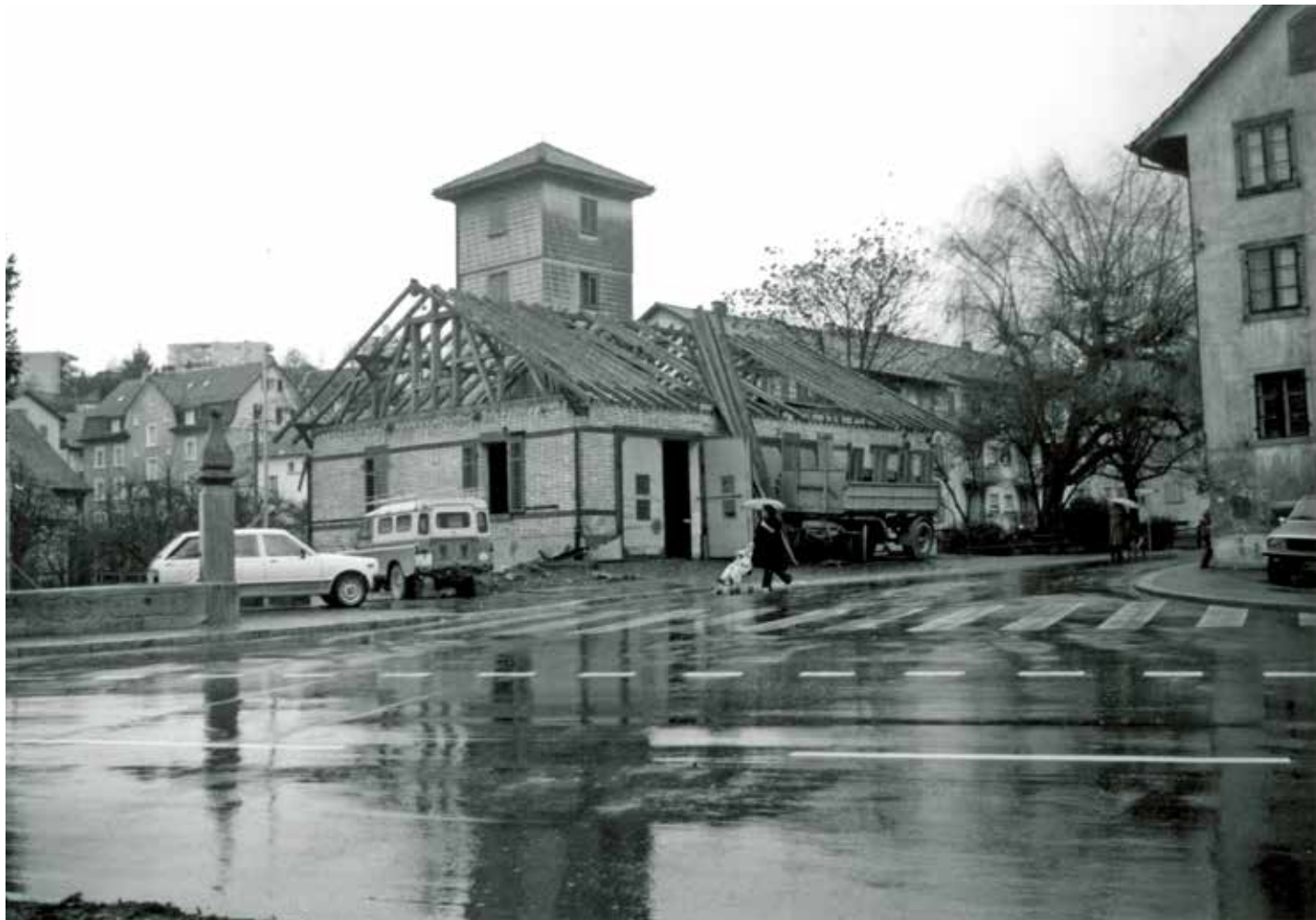
ca. 1979/1980: Abbruch des alten Feuerwehrdepots und Spritzenhauses an der Sägestrasse.
