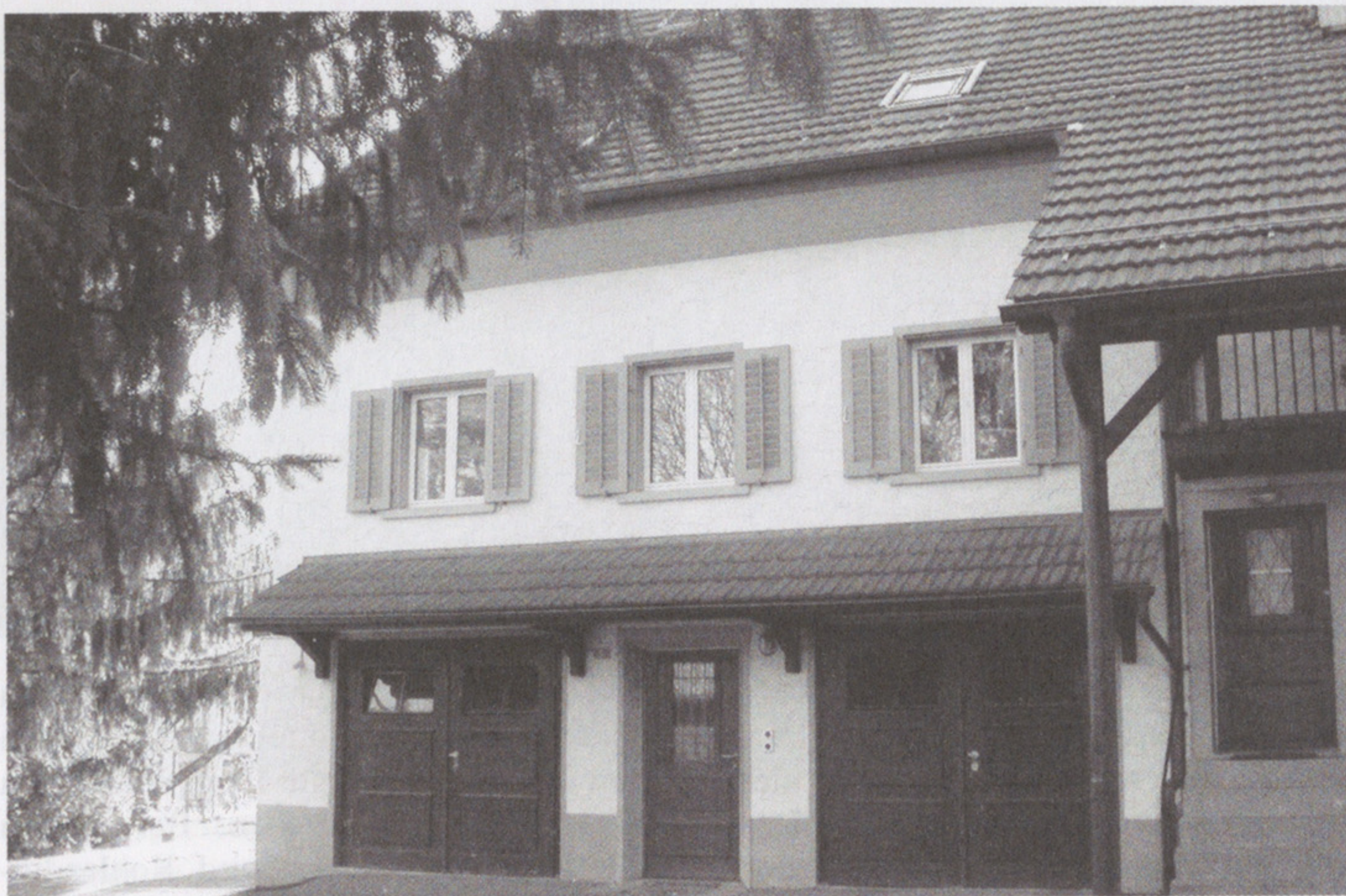
An der letzten Gemeindeversammlung wurde beschlossen, das Wohnhaus an der alten Zürichstrasse 5 umzubauen und als Kinderhort für Maur zu verwenden. Die Bauarbeiten werden Mitte November beginnen. (Foto: go)
