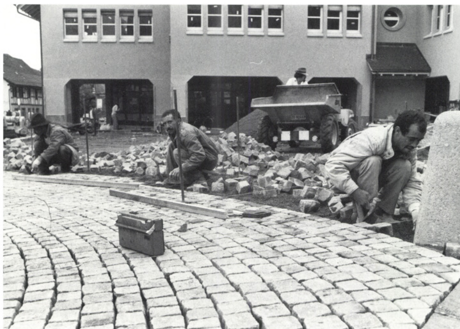
Liebevoll setzen Pflasterer einen Stein um den andern in den sandigen Boden vor dem Neubau der Zürcher Kantonalbank. Die vermitteln damit dem Platz ein ganz besonderes Gepräge.
