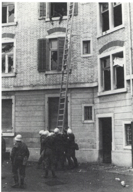
Aus dem Konsumgebäude werden über die Leiter Schwerverletzte gerettet.
