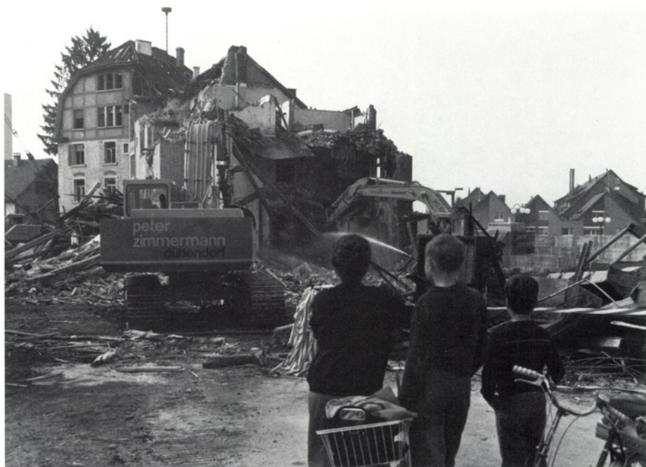
Viele standen mit gemischten Gefühlen am Strassenrand, als Anfang September eine Baufirma damit beschäftigt war, das alte Konsumgebäude abzutragen.
