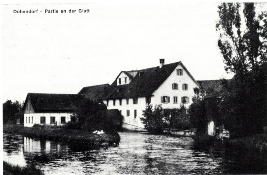
Die Obere Mühle etwa im Jahre 1905 von der Unterwasserseite her gesehen. In der Mitte das Mühlengebäude, links auf der Insel die Senfmühle und dazwischen das überdeckte Wasserrad.
