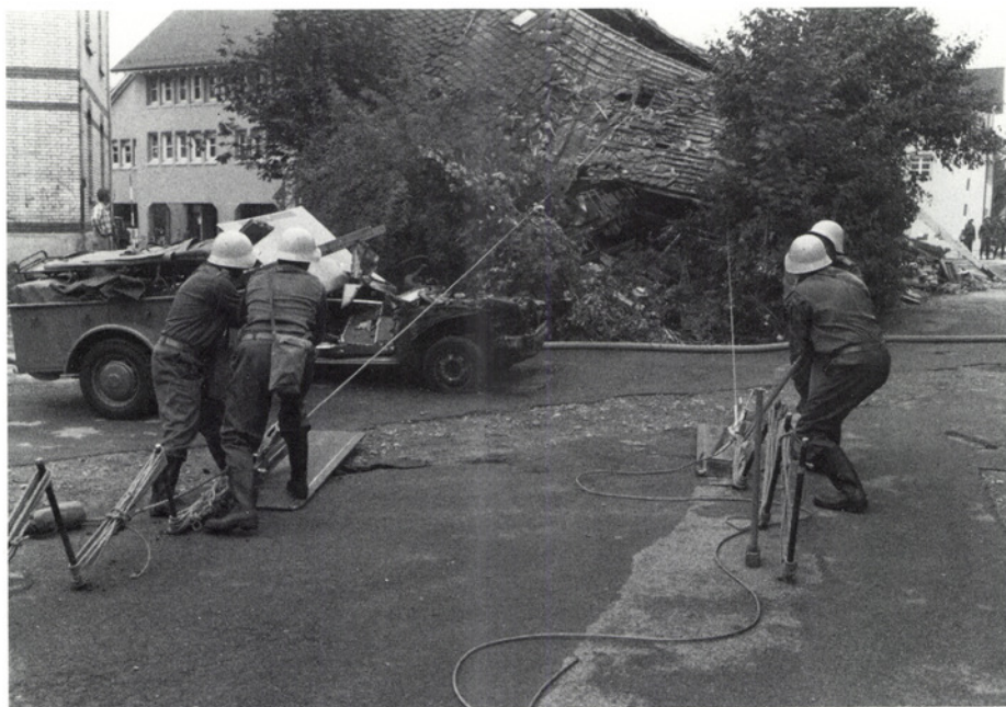
Angehörige des Pionier- und Brandschutzdienstes beginnen mit dem Abbruch einer alten Liegenschaft an der Usterstrasse.
