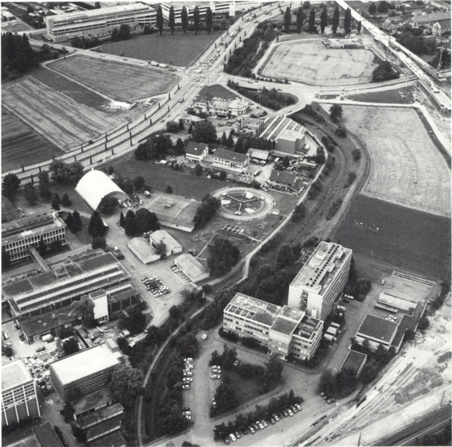
Unsere Luftaufnahme zeigt vorne rechts die Gebäude der jubilierenden EAWAG, links sind Liegenschaften der EMPA, rechts oben der Neugut-Viadukt der S-Bahn zu erkennen.
