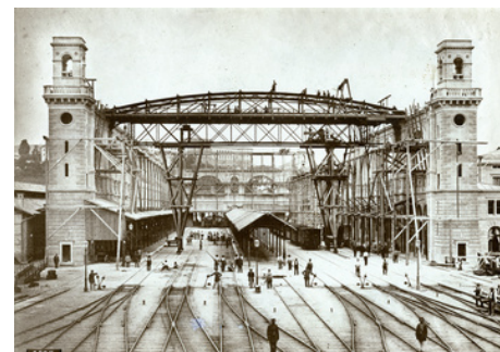
Der neue Hauptbahnhof im Bau 1867 (Foto: BAZ_098164)
