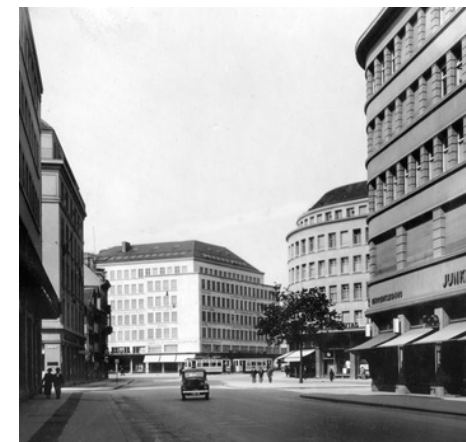
1934: Modernität an der Sihlporte (Foto: BAZ_078544)
