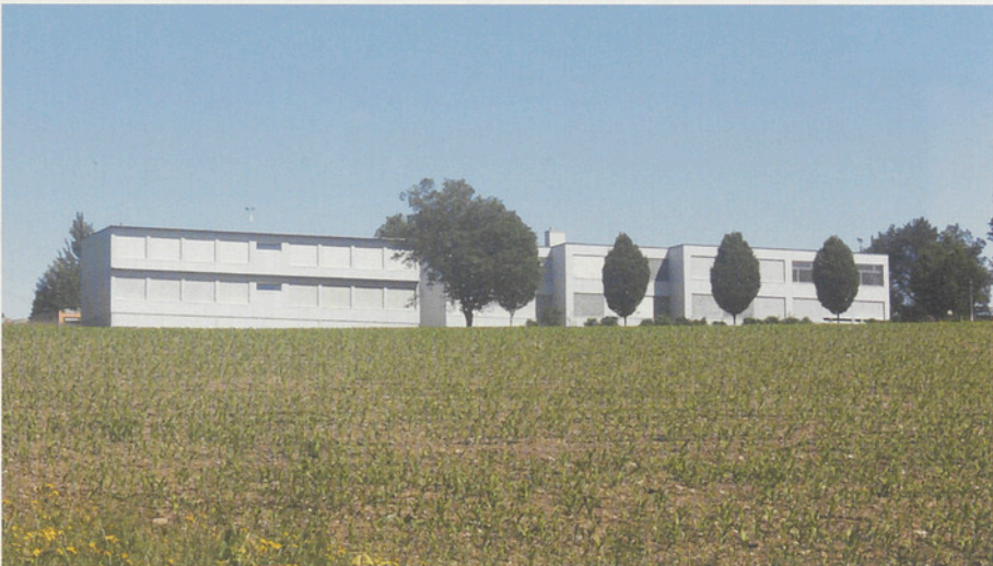
Das erweiterte Schulhaus Bachwis, Winterberg
