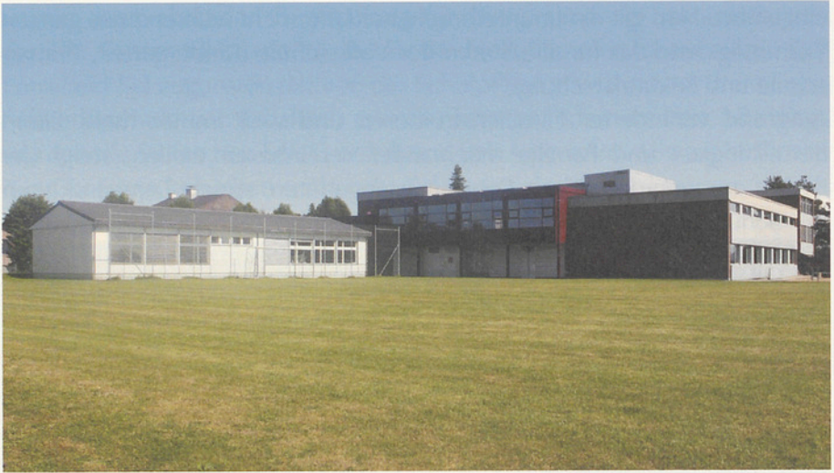
Pavillon beim Schulhaus Buck
