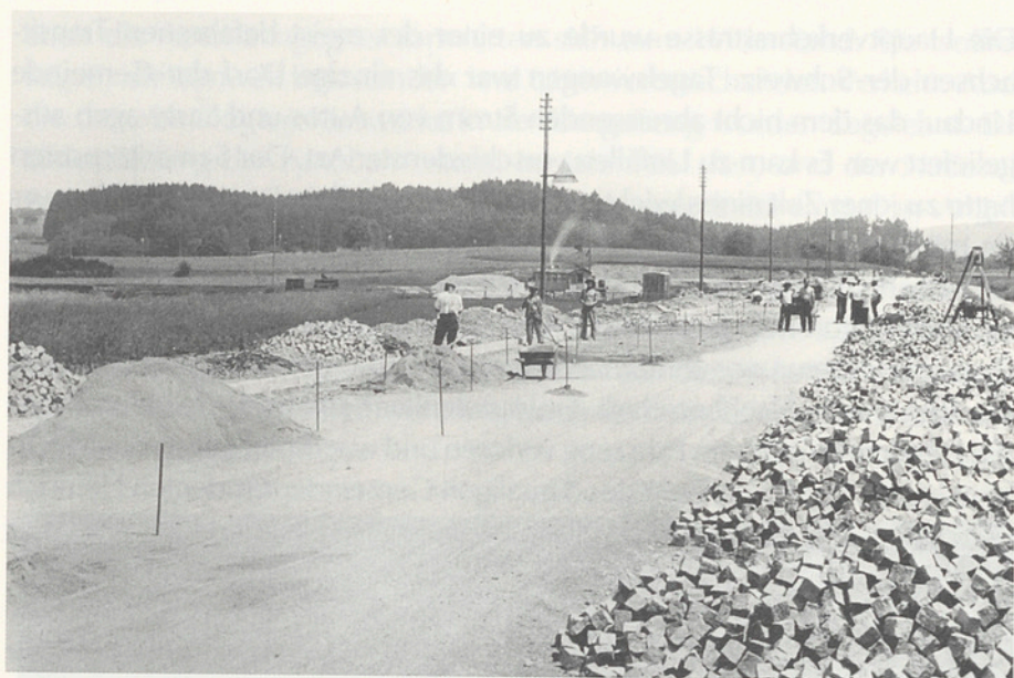
Ausbau der Kantonsstrasse Tagelswangen–Kemptthal um 1930 beim Neuhof
