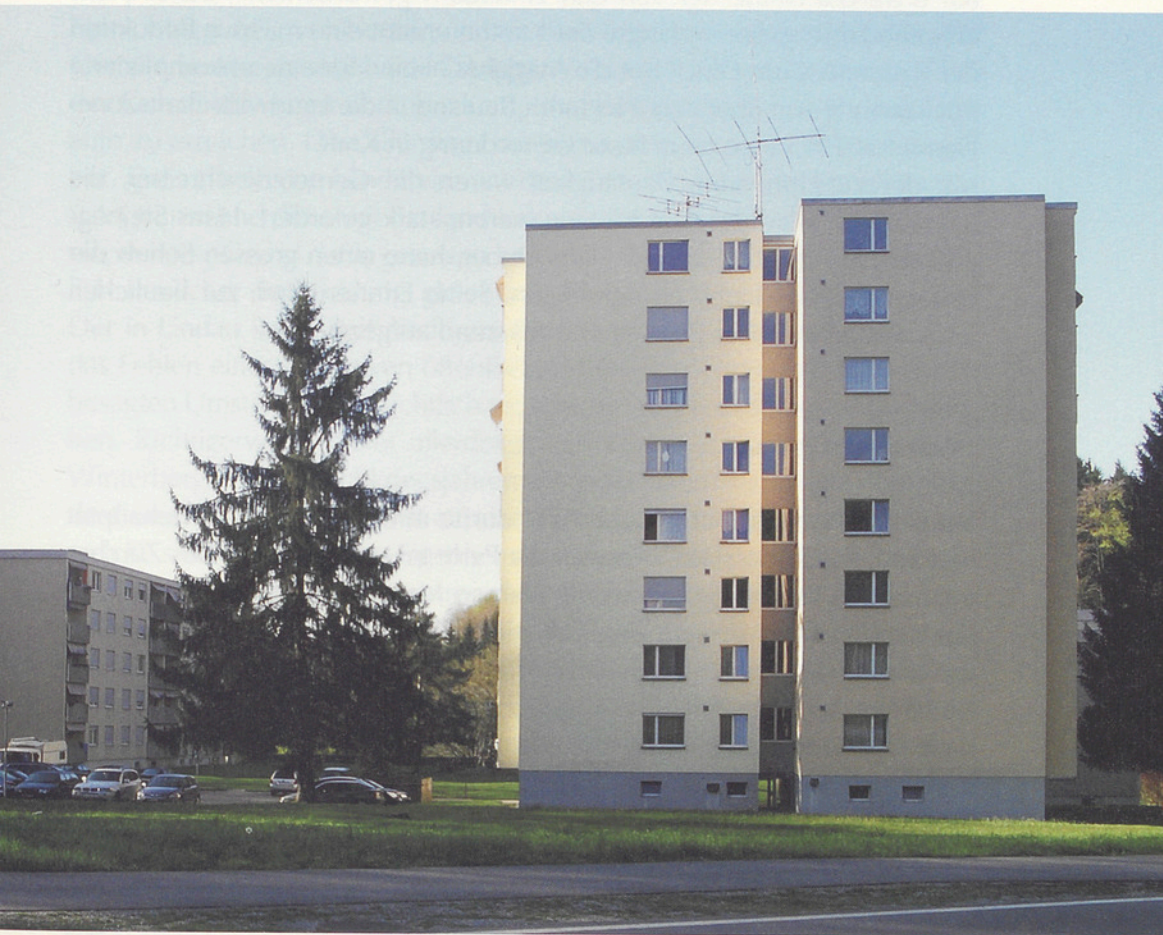
Oberwis in Tagelswangen, das einzige Hochhaus in der Gemeinde
