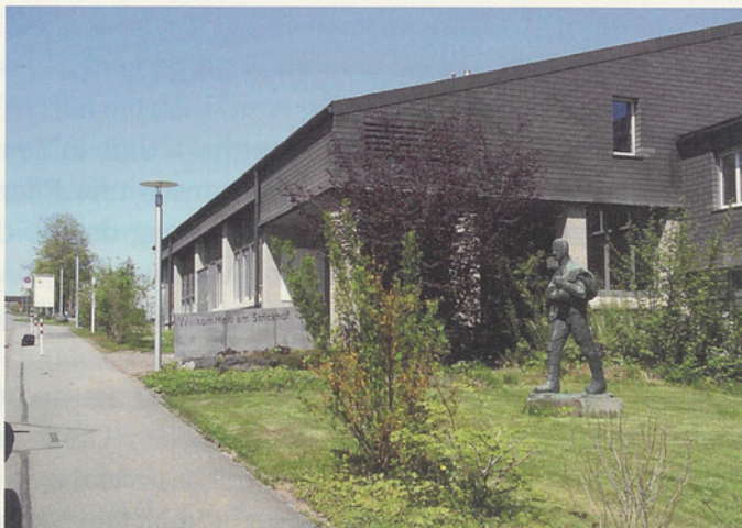
Strickhof, Haupteingang zum Schulgebäude
