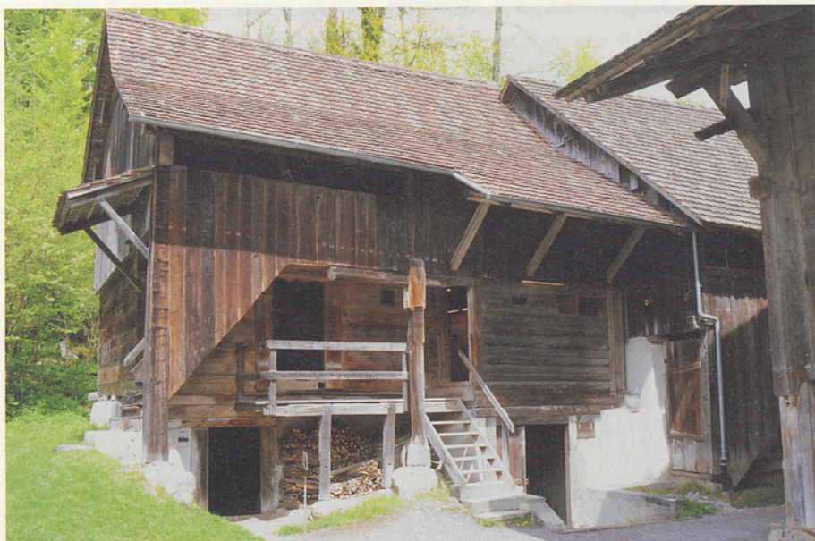
Der alte Speicher Tagelswangen im Ballenberg
