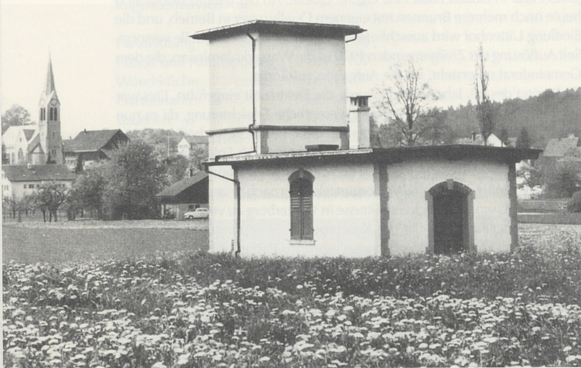
Das Pumpwerk in Lindau
