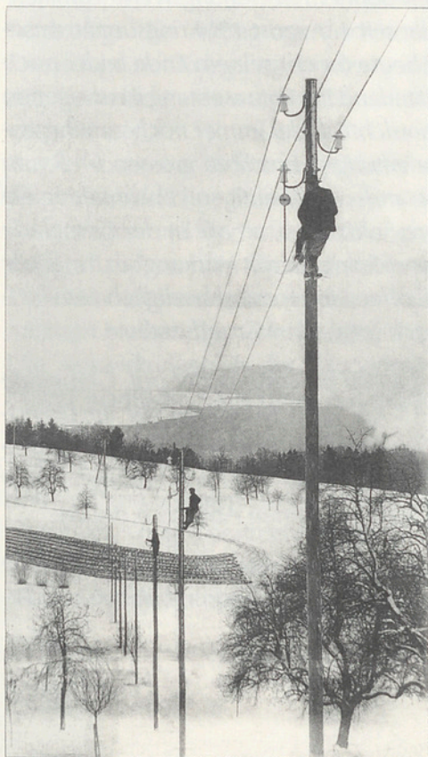
Unterhaltsarbeiten an Freileitungen im Kanton Zürich im Jahr 1914
