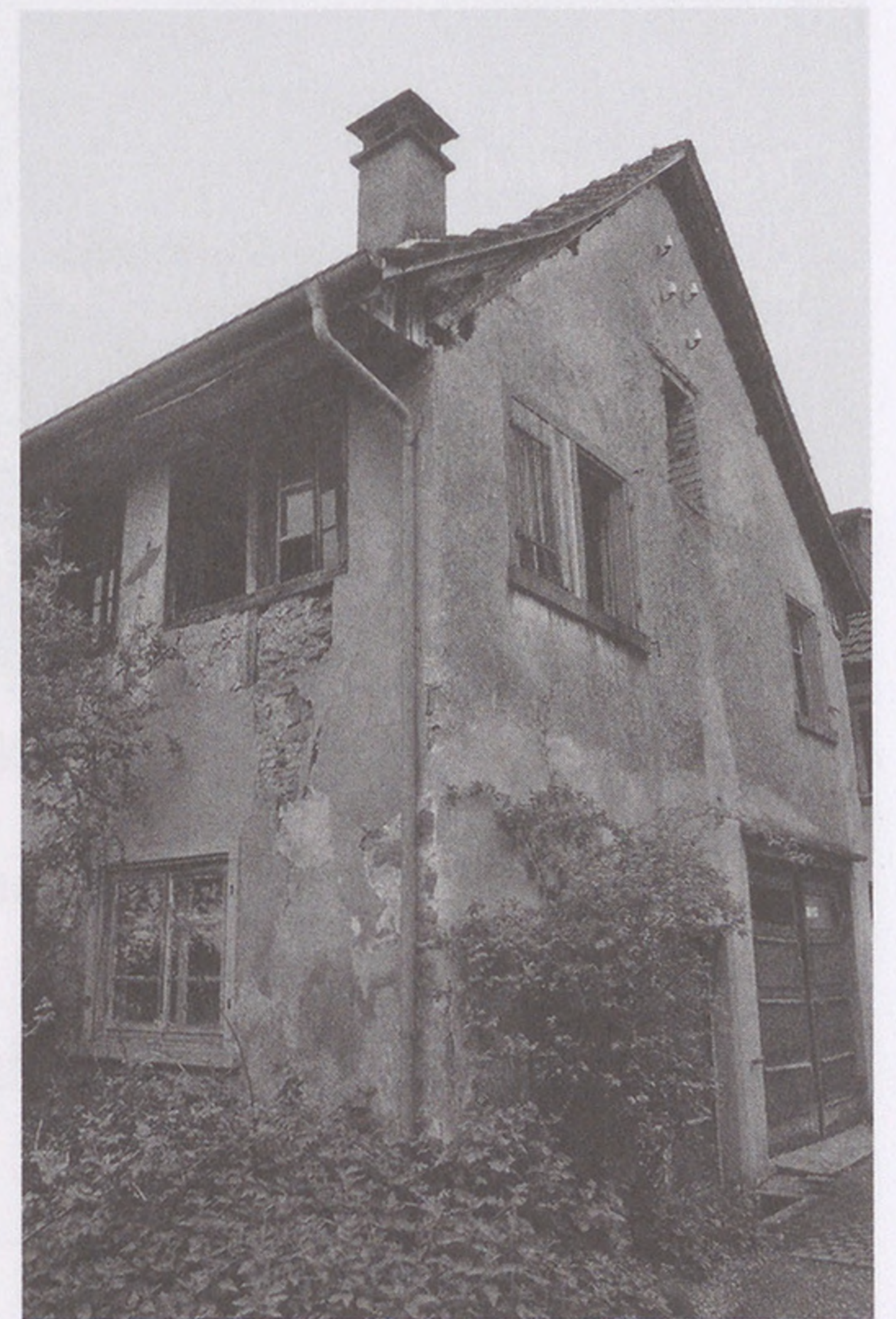
Dieses Abbruchgebäude steht nicht etwa in einem abgelegenen Dorf am Ostrand Anatoliens, sondern mitten im Dorf Maur, am Bäckerrain, etwas oberhalb der Post. Seit über 35 Jahren ist das Geisterhaus unbewohnt. Lohnt sich ein Ersatzbau nicht, weil es billiger ist, auf der grünen Wiese am Dorfrand zu bauen? Mit weiteren Neueinzonungen fehlt der wirtschaftliche Druck, zuerst Ruinen zu beseitigen. Wollen wir das wirklich? Helfen Sie mit, die Zukunft von Maur zu beeinflussen und besuchen sie die Gemeindeversammlung vom 7./8. Juni!
