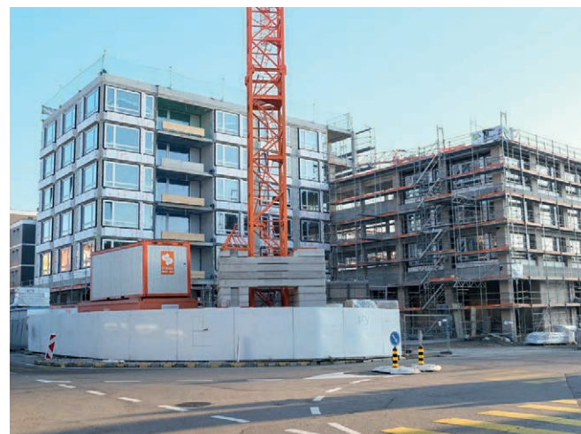
Rechtzeitig auf den Winter: Die Fenster der Neubauten sind montiert
