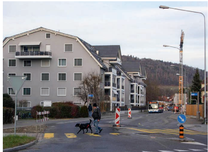
Auf der Fahrweidstrasse soll künftig zwischen Überland- und Querstrasse Tempo 30 gelten
