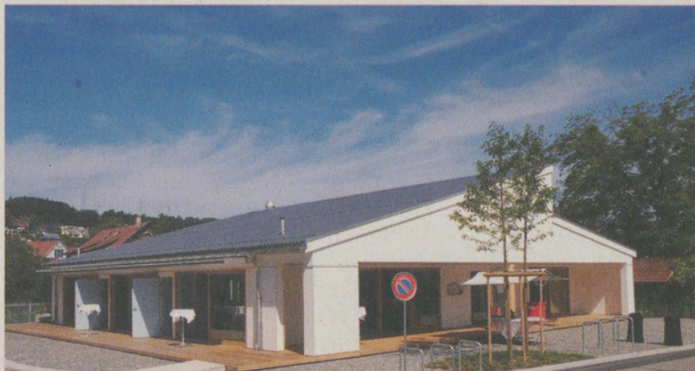
Das neue Kirchgemeindehaus Kreuzbühl.
